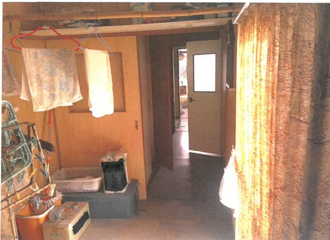
物件 4 内部状況
