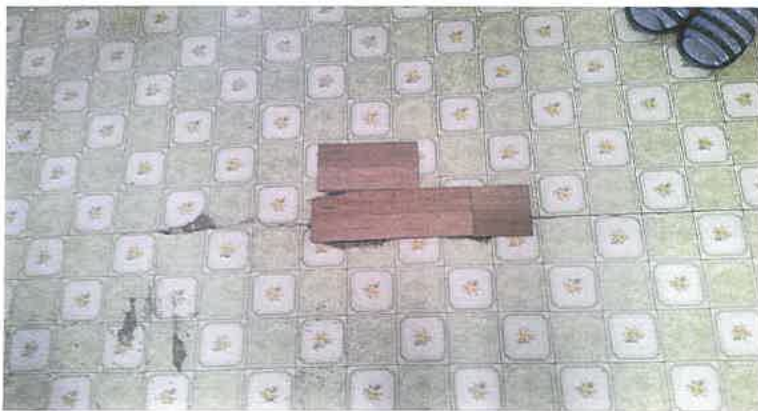
物件4 2階内部状況
