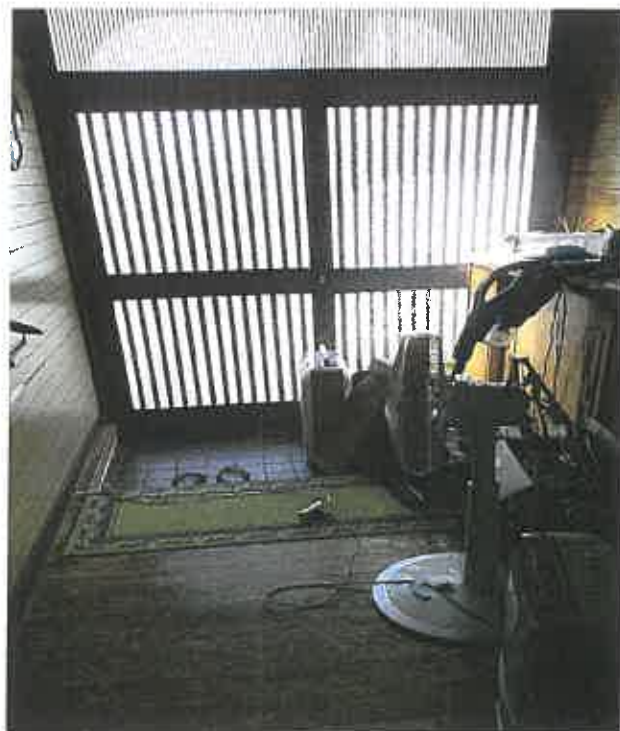
物件4 2階内部状況
