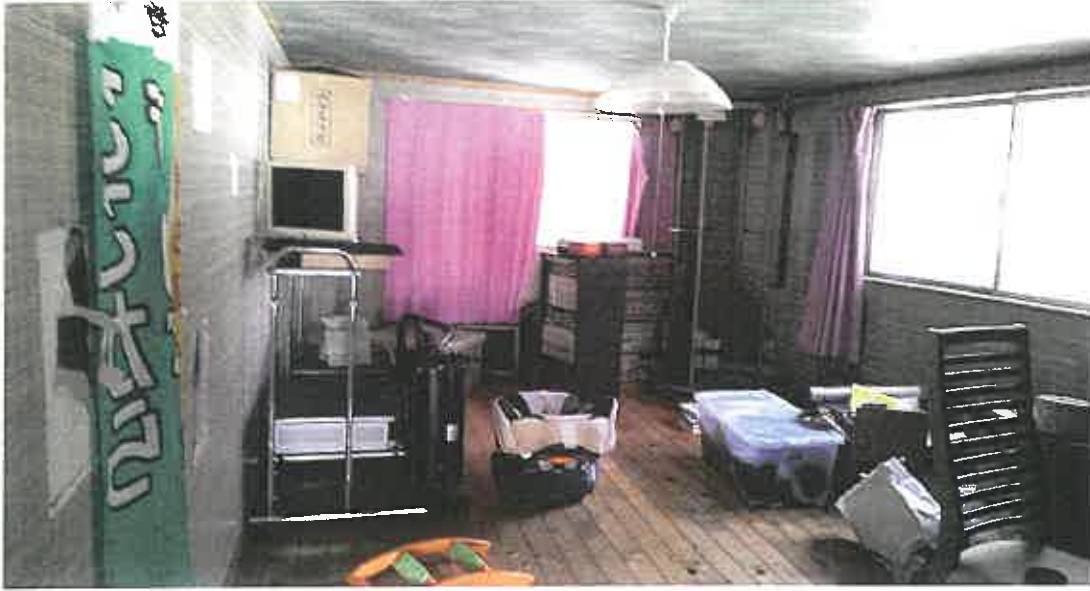
物件2 未登記附属建物内部状況
