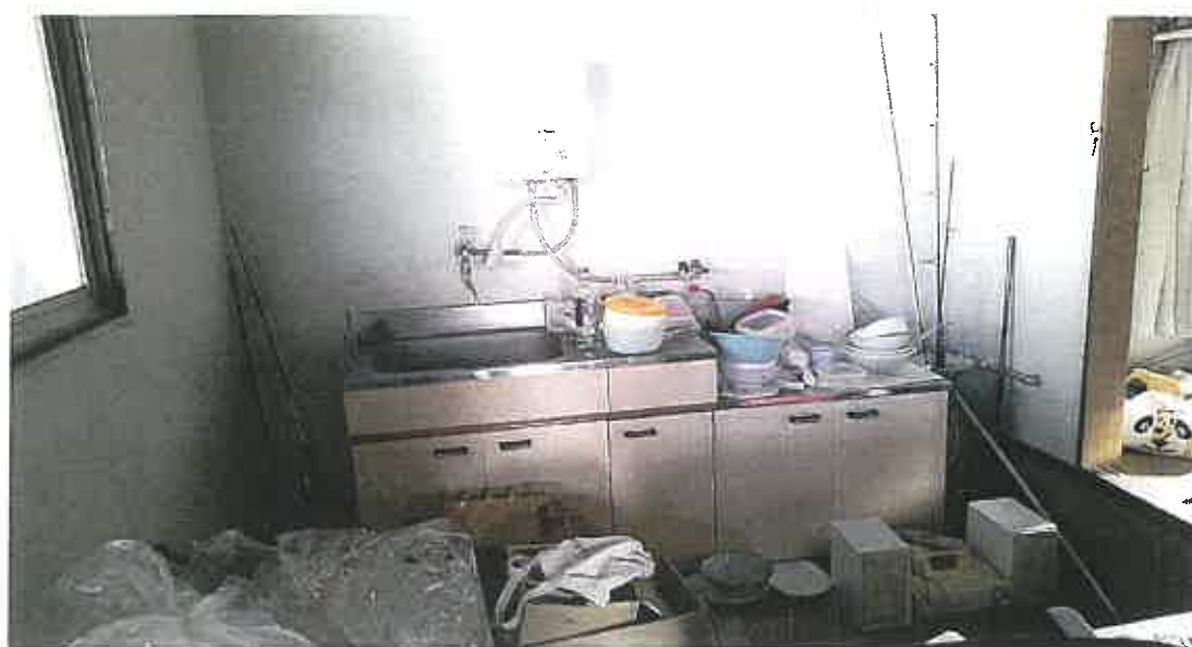
物件2 1階内部状況
