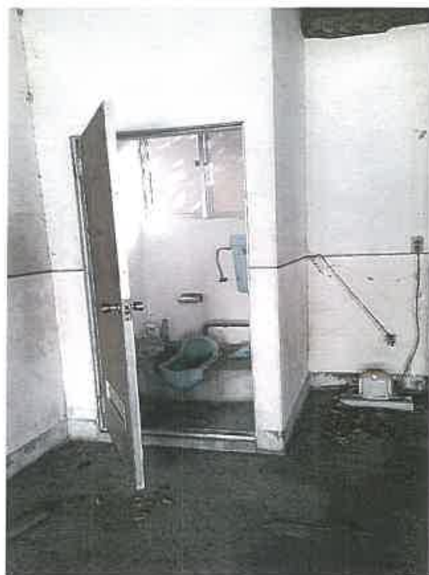
物件2 1階内部状況
