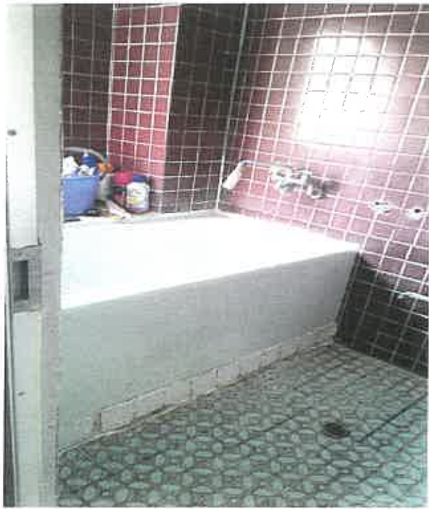
物件 4 2階内部状況
