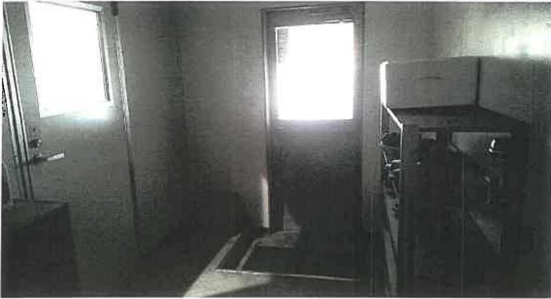
物件 2 内部状況
