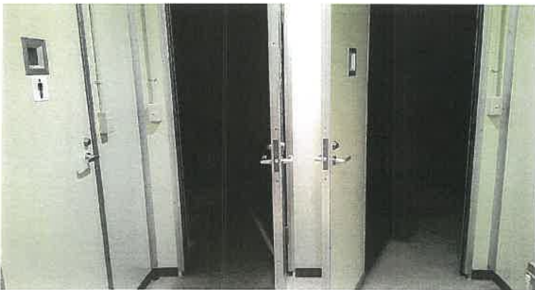
物件2 内部状況
