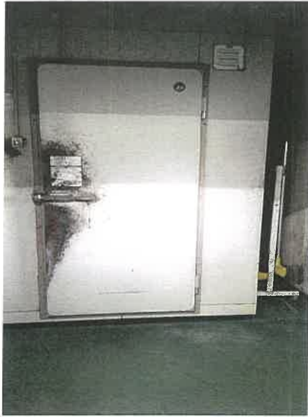
物件2 内部状況
