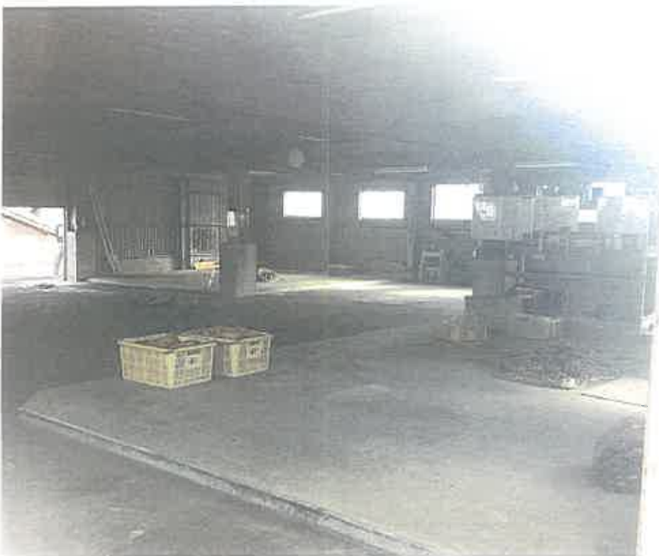
物件8内部状況
