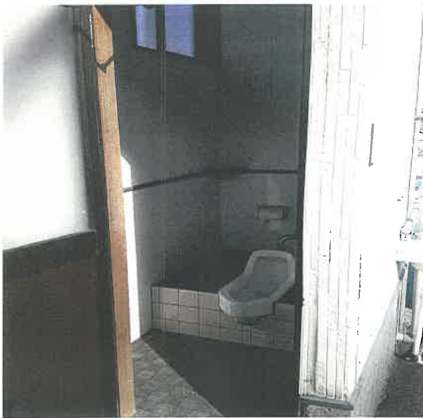
未登記附属建物 内部状況
