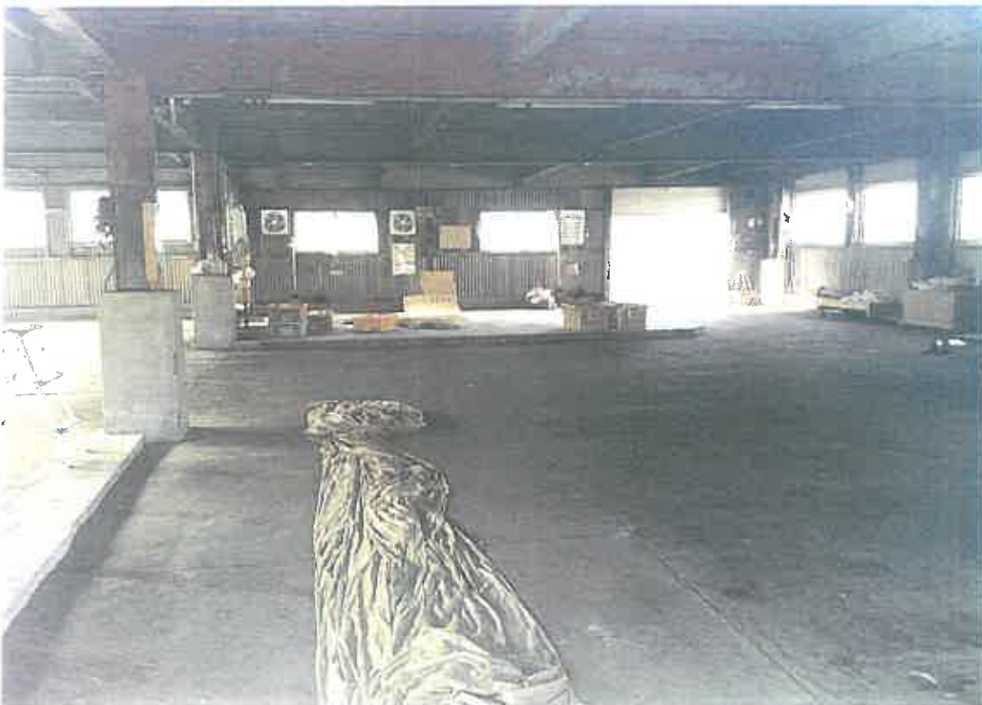
物件8 内部状況
