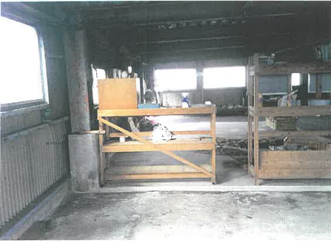
物件8 内部状況
