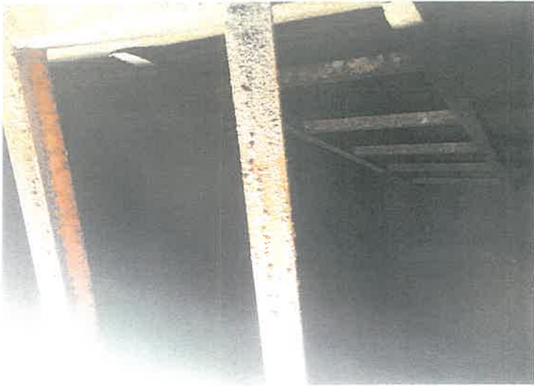
物件8 地下室の内部状況
