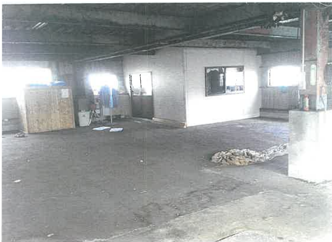
物件8 内部状況
