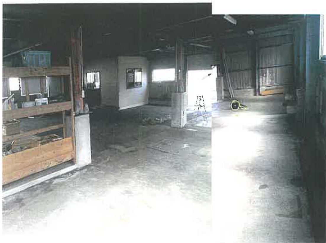
物件8 内部状況
