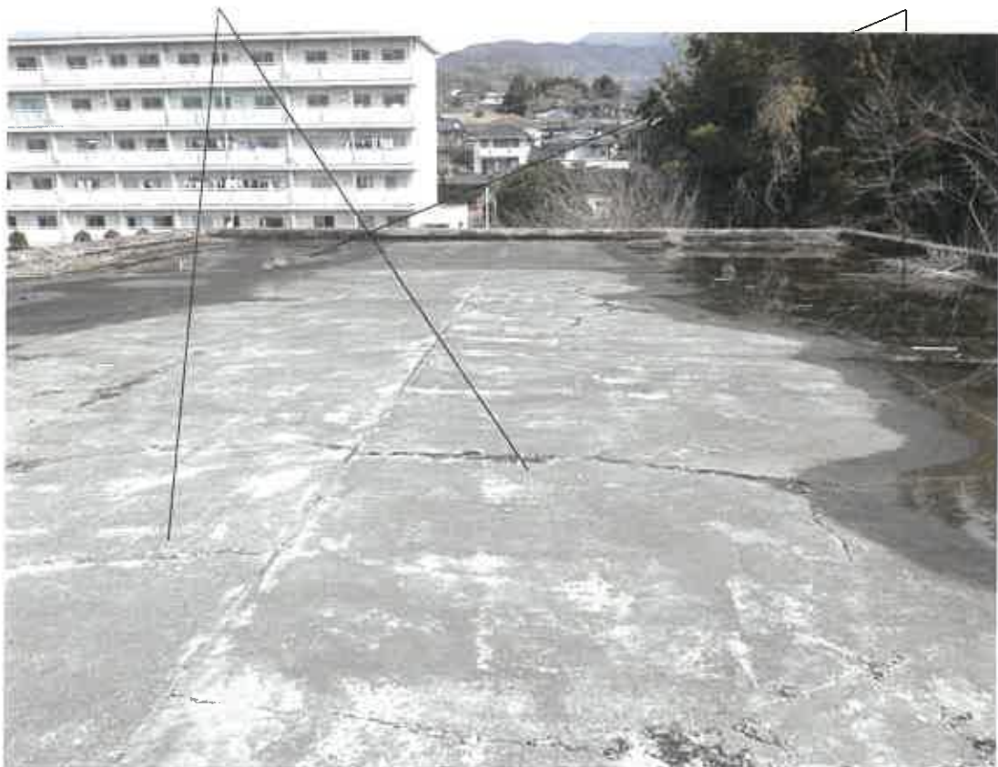
本件建物の屋上部分の亀裂 本件建物の屋上に雨水が溜まった状況
