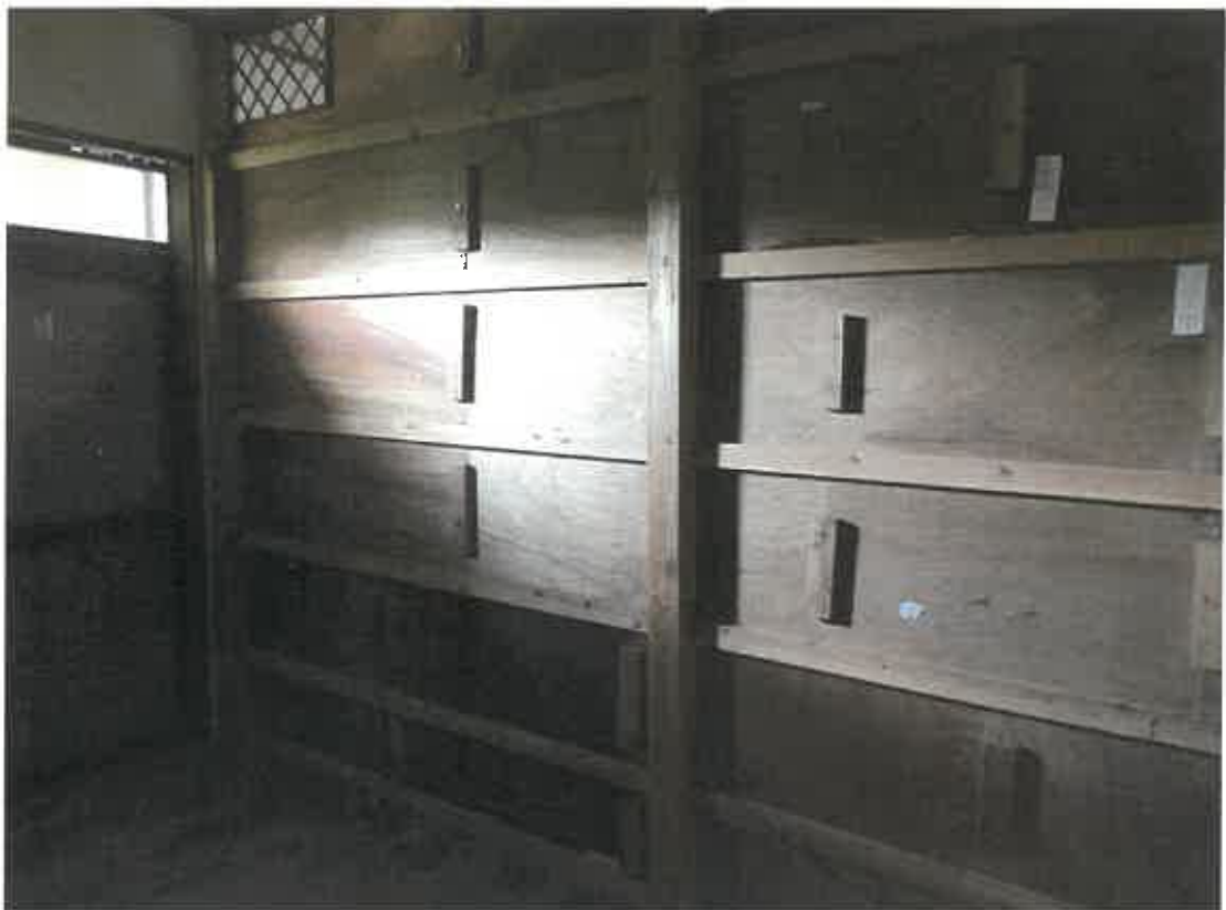
写真 8 乃至 14 は本件建物内部
