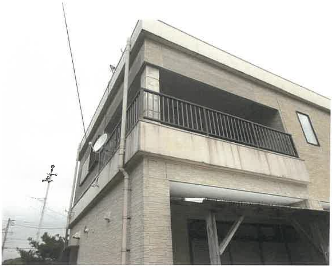
本件建物の増築部分
