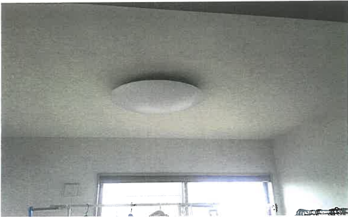
物件2 1階内部状況
