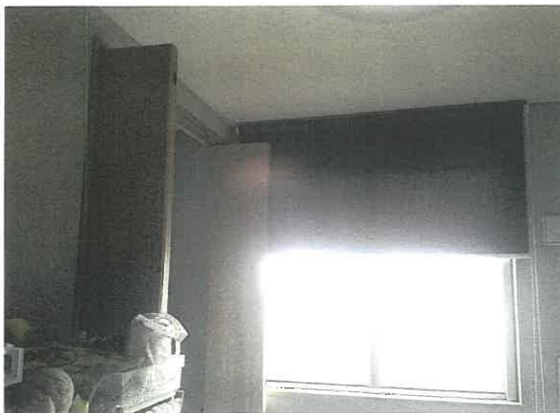
物件2 2階内部状況
