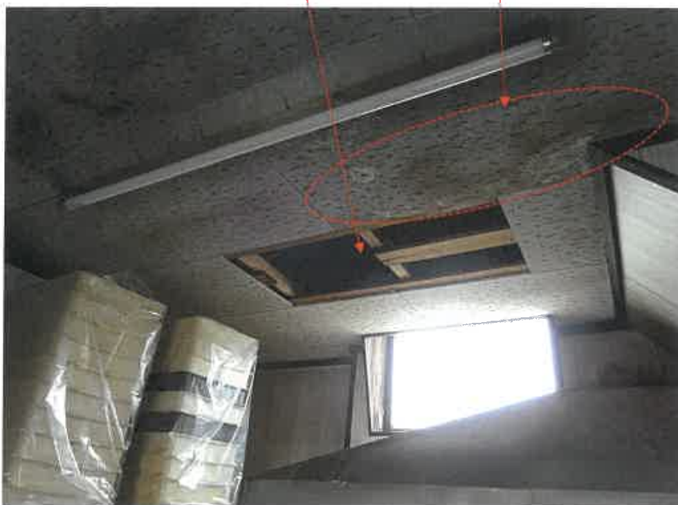
写真10 本件建物内部(2階)
