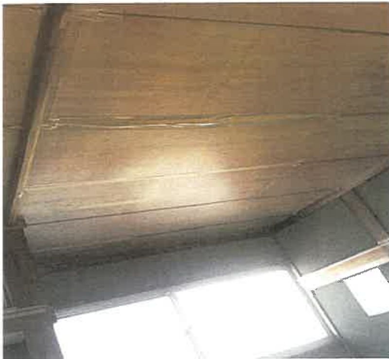
物件2 2階内部状況
