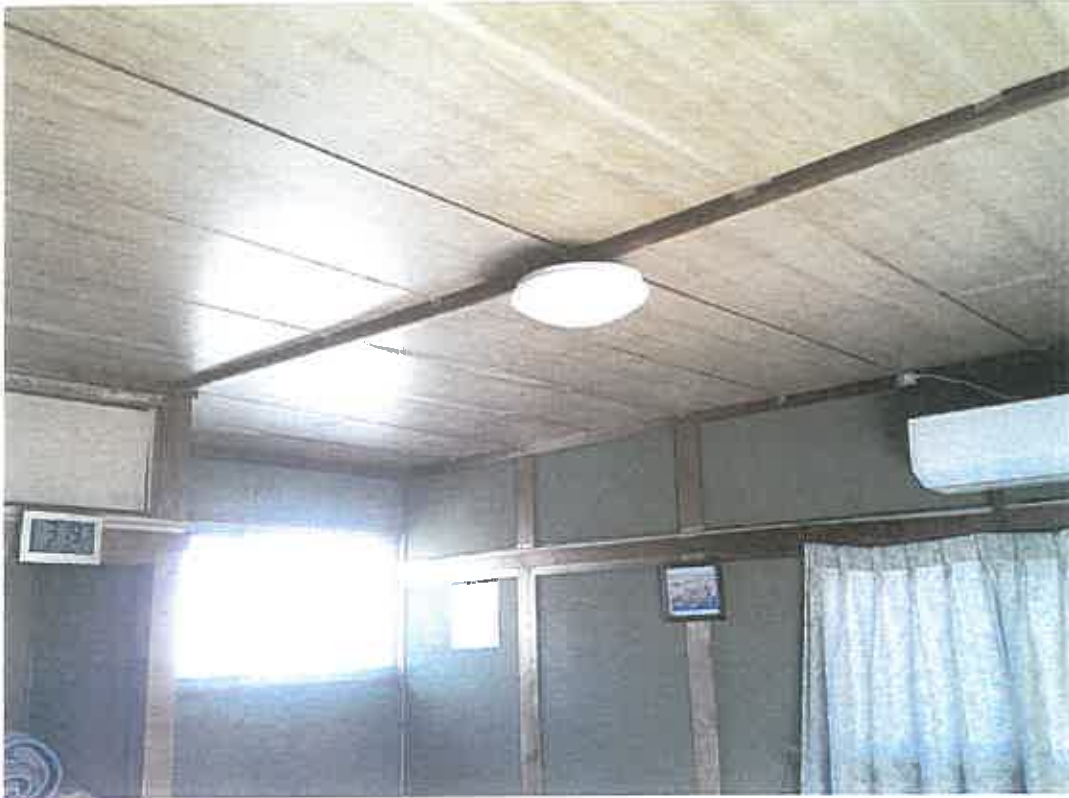
物件2 2階内部状況
