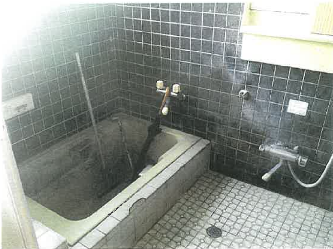
物件2 1階内部状況
