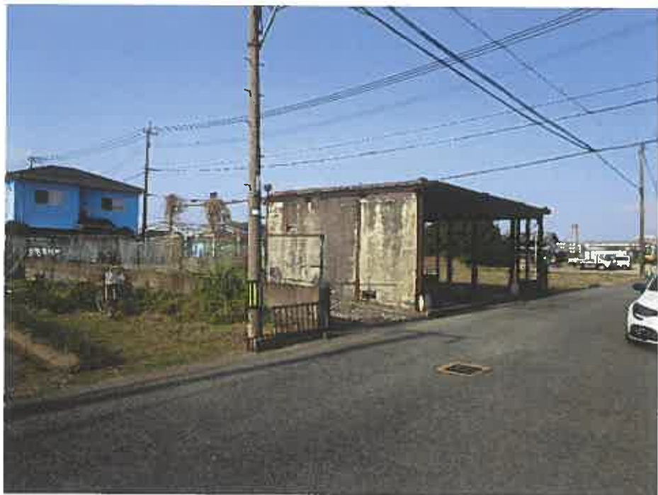
物件南東方より撮影
