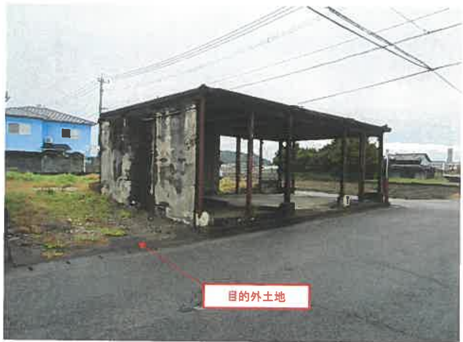
物件南東方より撮影
