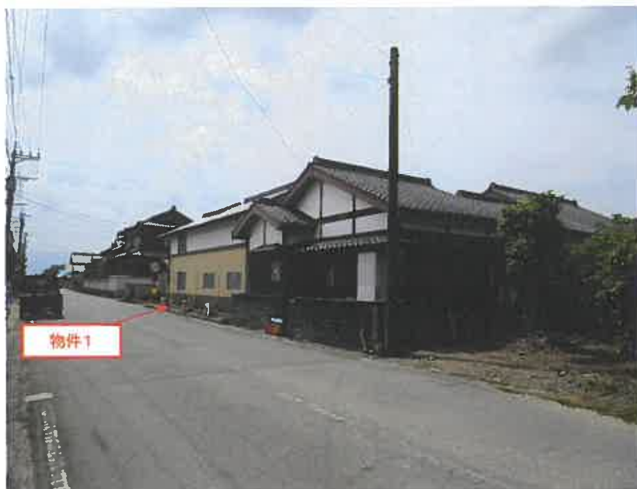
物件北方より撮影
