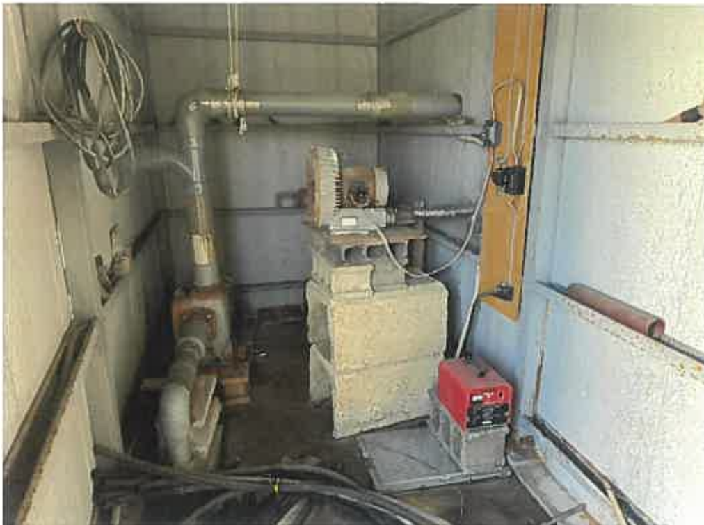
物件12（未登記附属建物2）：内部
