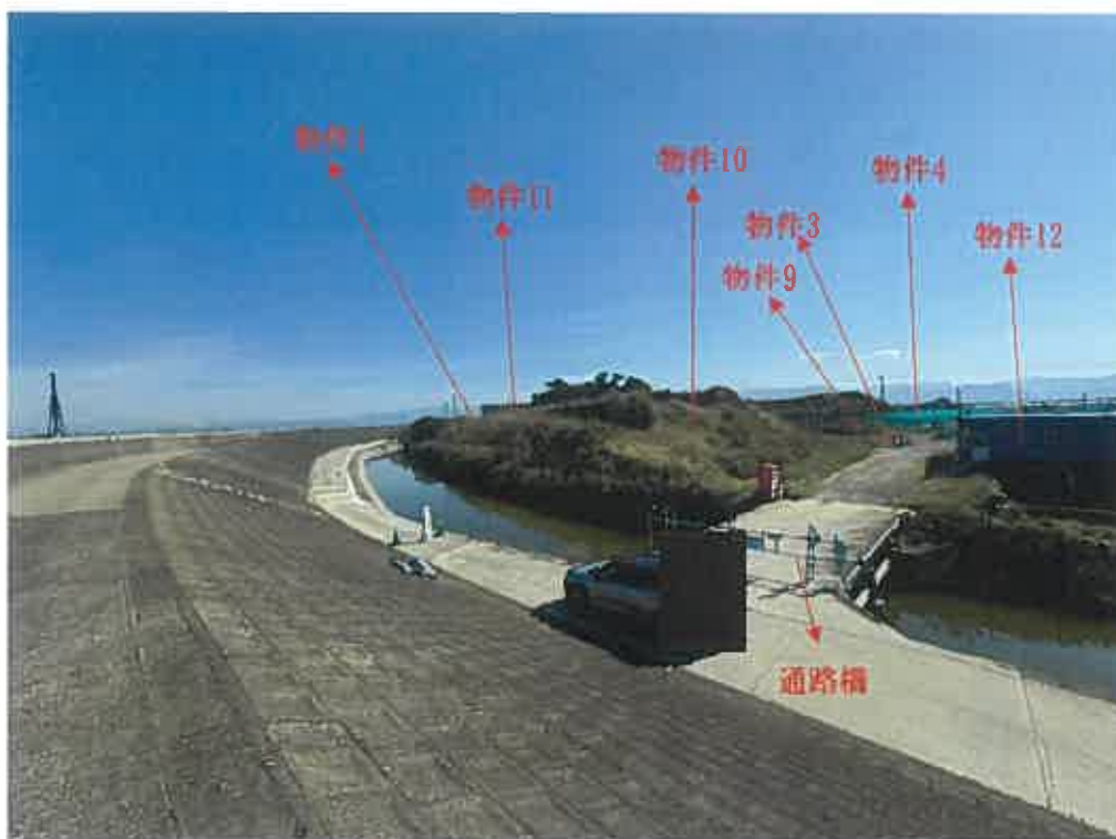
南西方より対象不動産を望む
