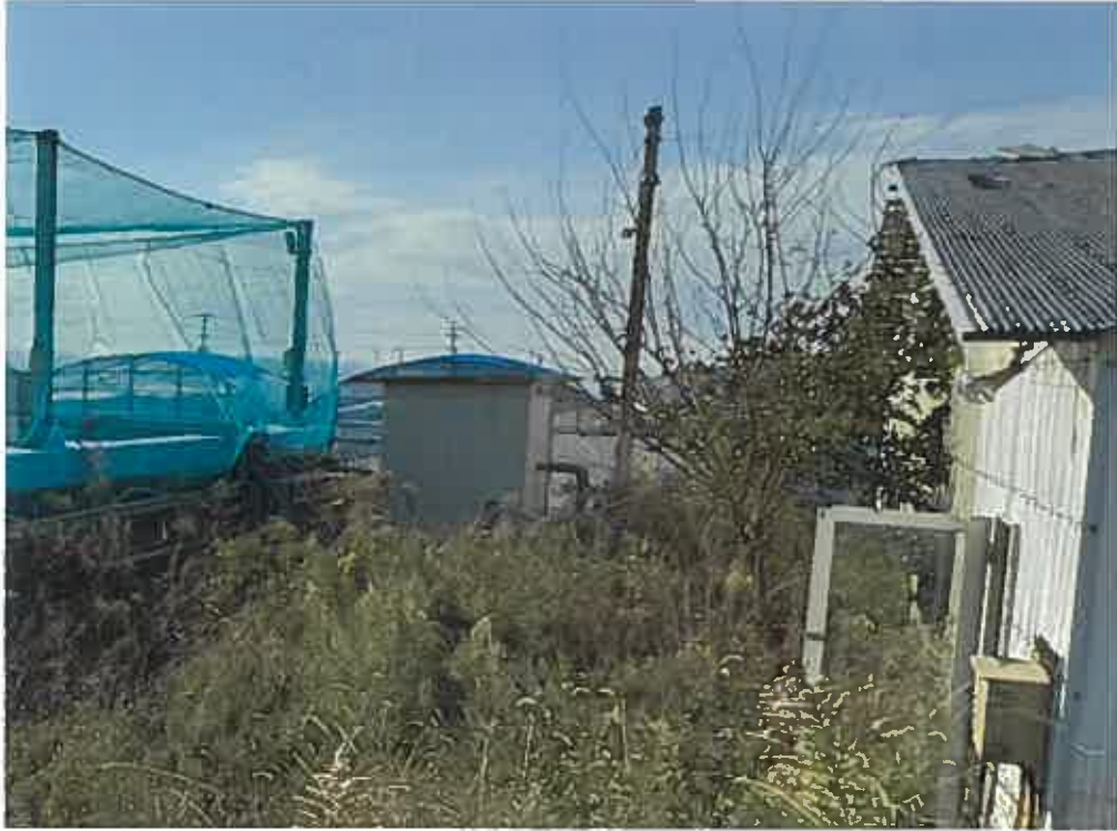
物件12（未登記附属建物2）：外観
