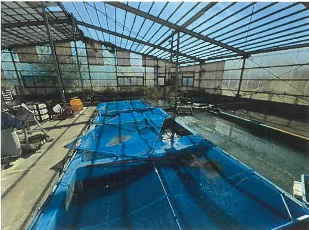
物件12（未登記附属建物1）：内部
