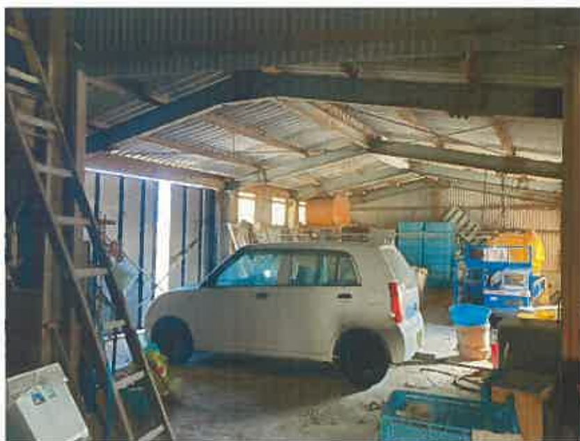
写真⑧：附属建物符号2(倉庫)
