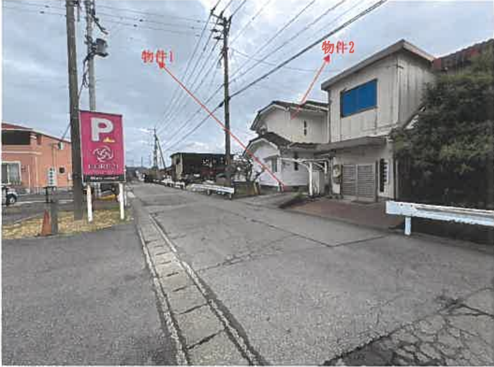
南西方より対象不動産（物件1及び物件2）を望む
