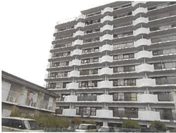
南側より対象マンション全景
