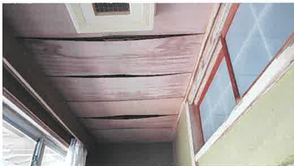
(写真 21 ) 広縁天井の損傷状況
