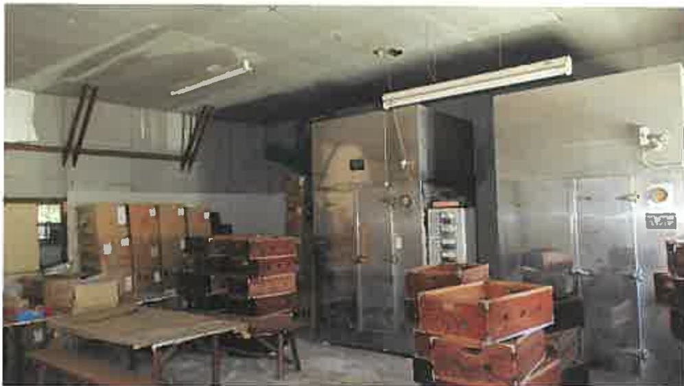
(写真 26 ) 物件 1 0 の附属建物符号 2 内部
