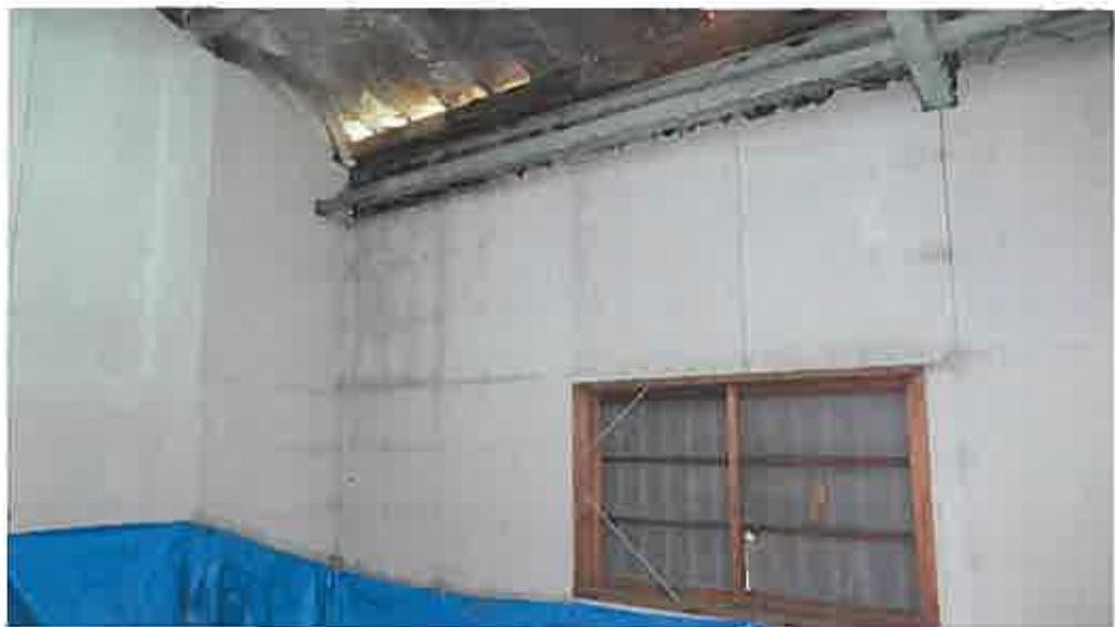
(写真 12 ) 屋根下の隙間及び内壁損傷状況
