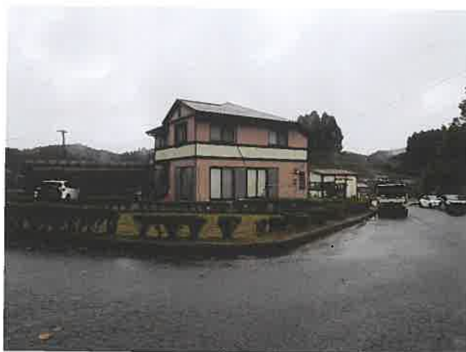
物件南方より撮影
