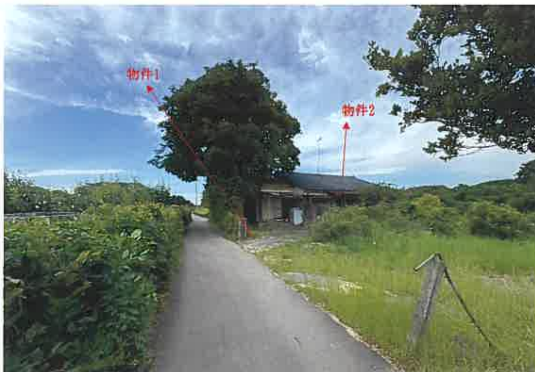
南西方より対象不動産を望む
