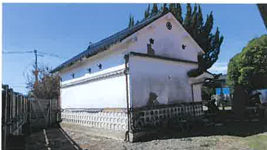
附属建物 2 の状況
