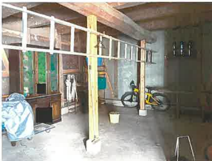
写真⑧：倉庫の内部
