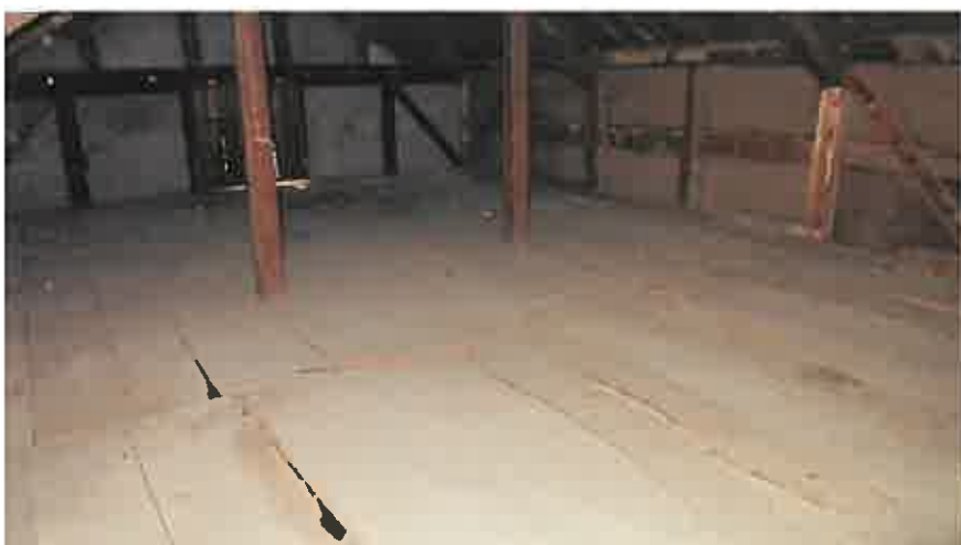
附属建物 2 ・ 2 階
