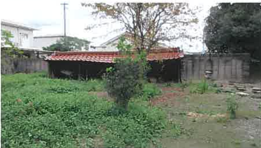
附属建物 5 の状況
