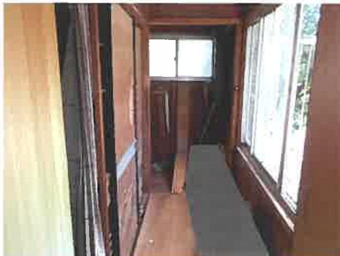
物件 2・2 階内部
