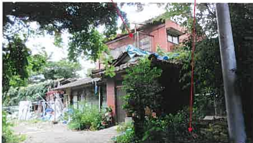
物件 2 (敷地が物件 1) 池跡
