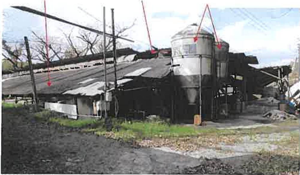
(写真 38 ) 件外建物 2 6
