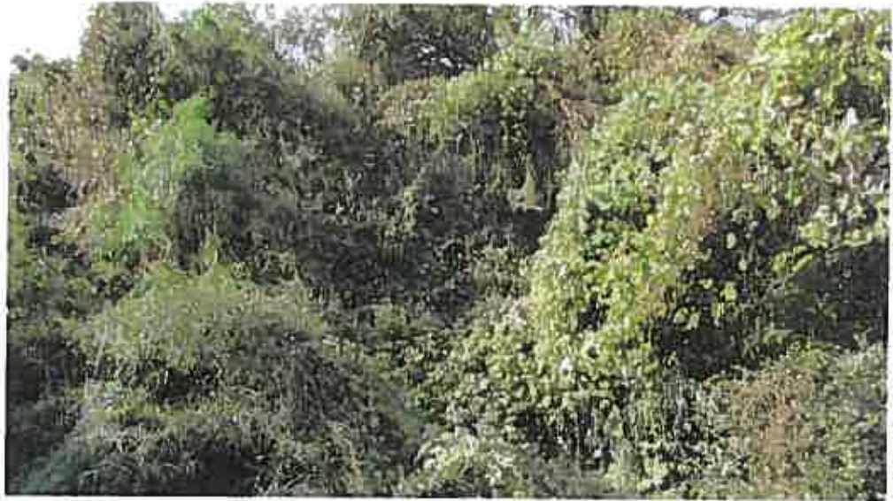
(写真 17 ) 物件 2 2 の状況 (南側から撮影)
