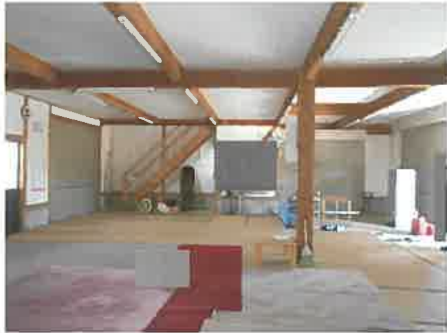
物件3・1階内部
