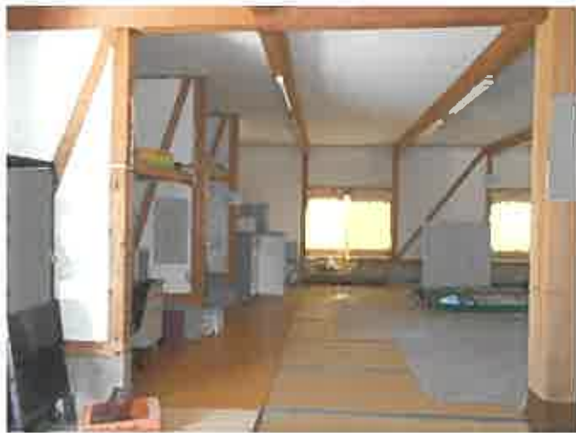
物件3・1階内部
