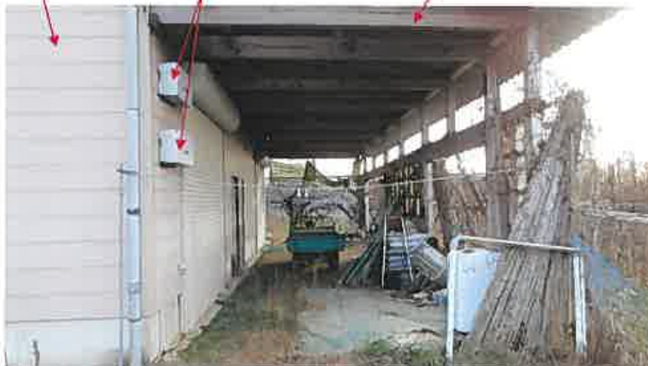
(写真 3 ) 物件3 太陽光発電システム用パワーコンディショナー 下屋
