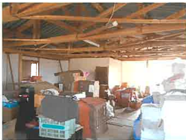
物件3・2階内部
