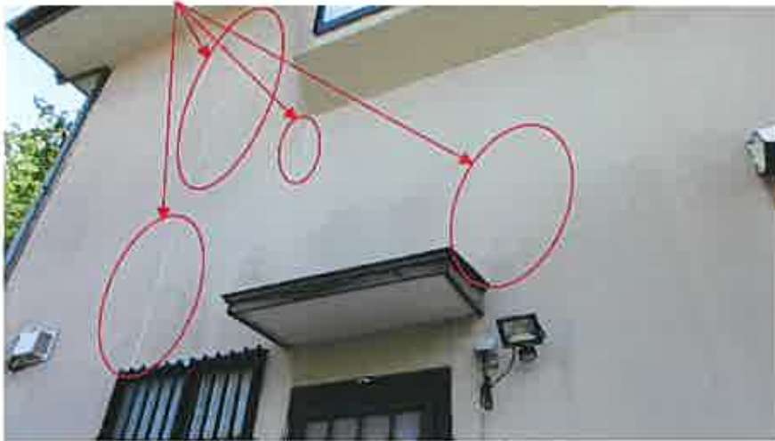
物件 2 ・外壁クラック修繕跡
