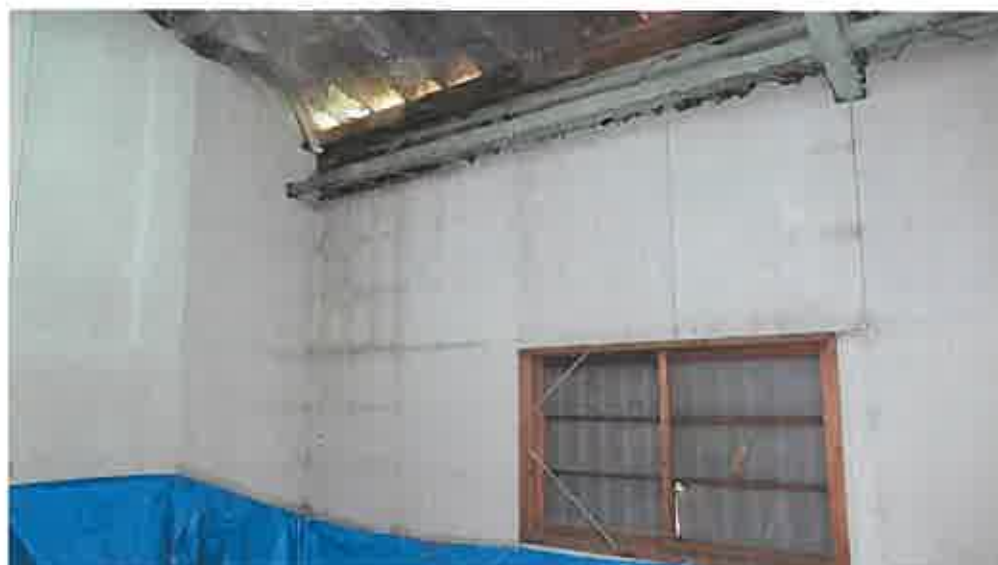
(写真 12 ) 屋根下の隙間及び内壁損傷状況
