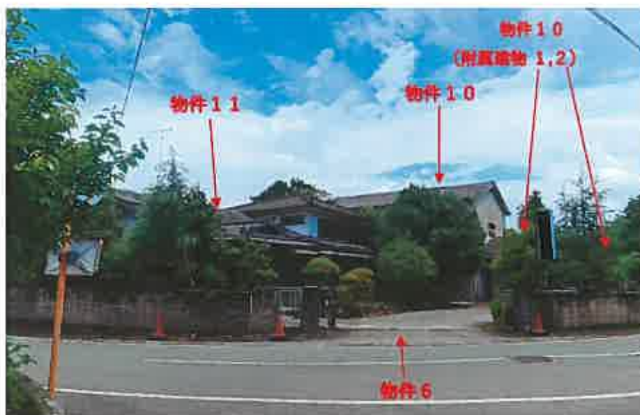
物件 1 0 (南西方より撮影)
