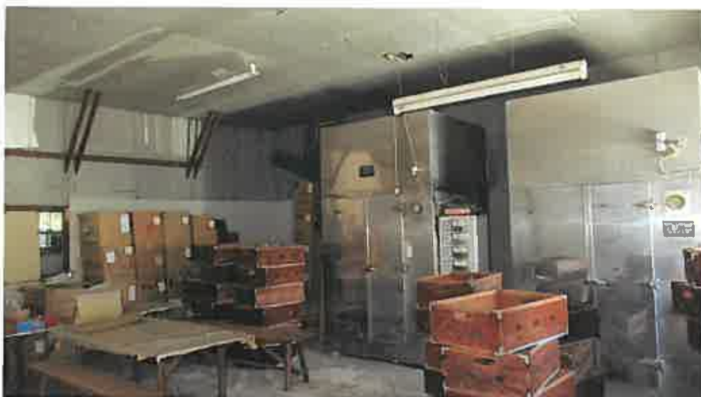
(写真 26 ) 物件 10 の附属建物符号 2 内部
