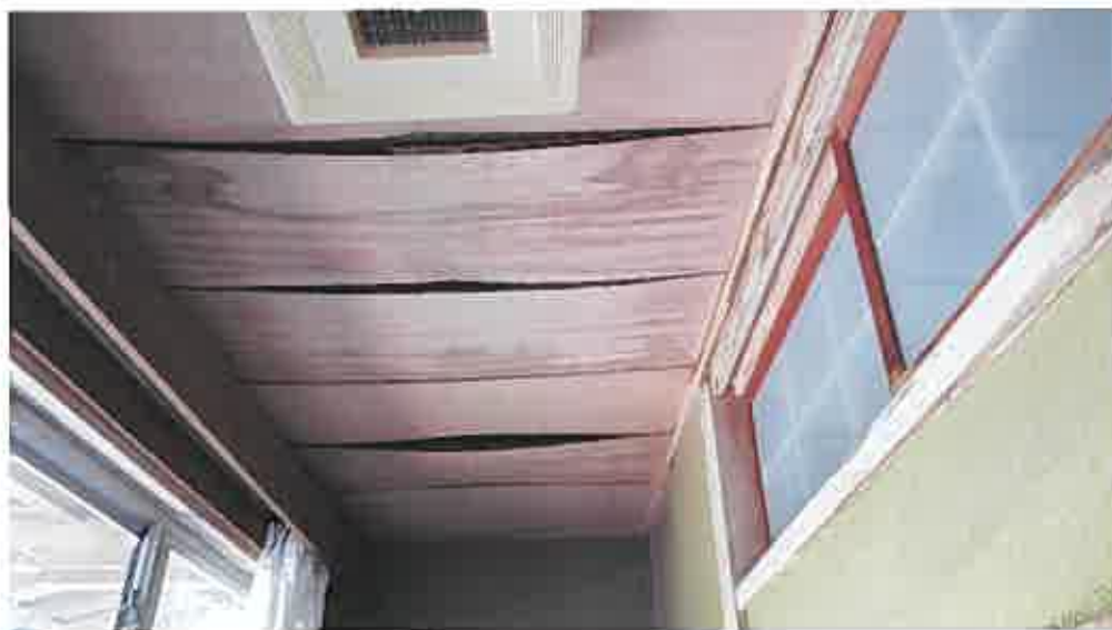
(写真 21 ) 広縁天井の損傷状況
