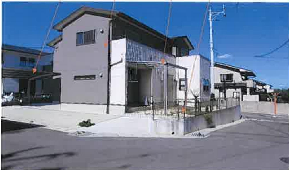
(写真2) ヒートポンプ給湯機 カーポート 物件4 物件1
