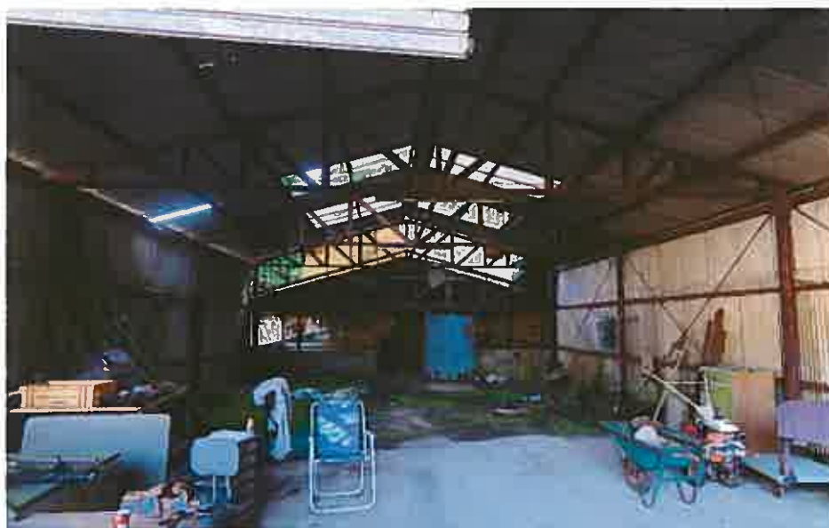
目的外建物内部 (作業場)
