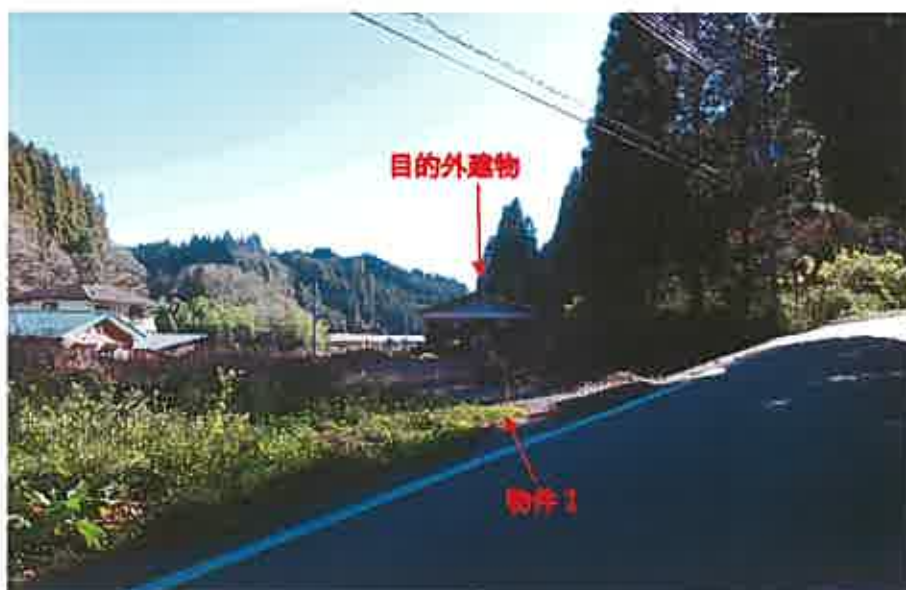
物件1 (北西方より撮影)
