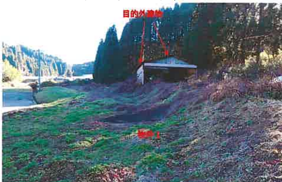
物件1 (北方より撮影)
