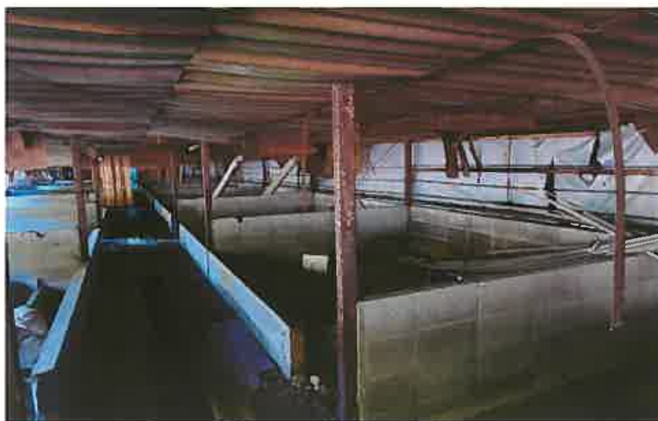
目的外建物内部 (畜舎)
