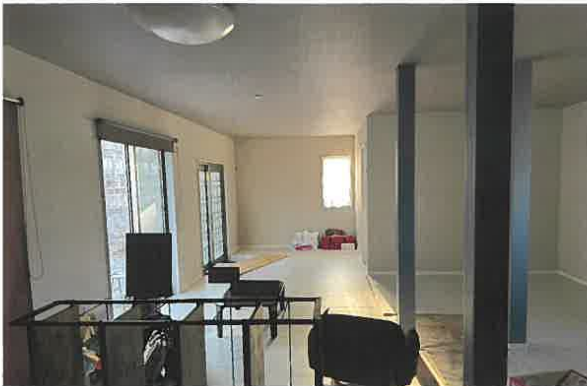
物件1（主である建物）：内部
