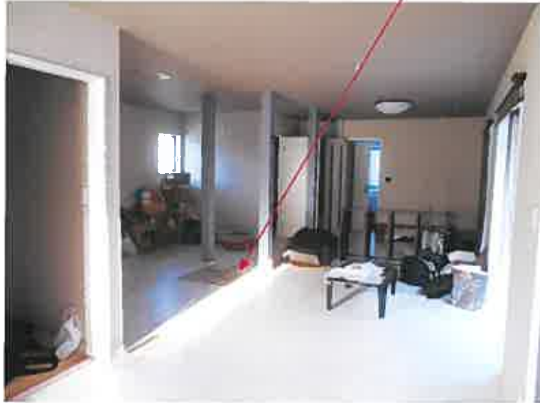
(写真 8 ) 1階 未完成の西側玄関
