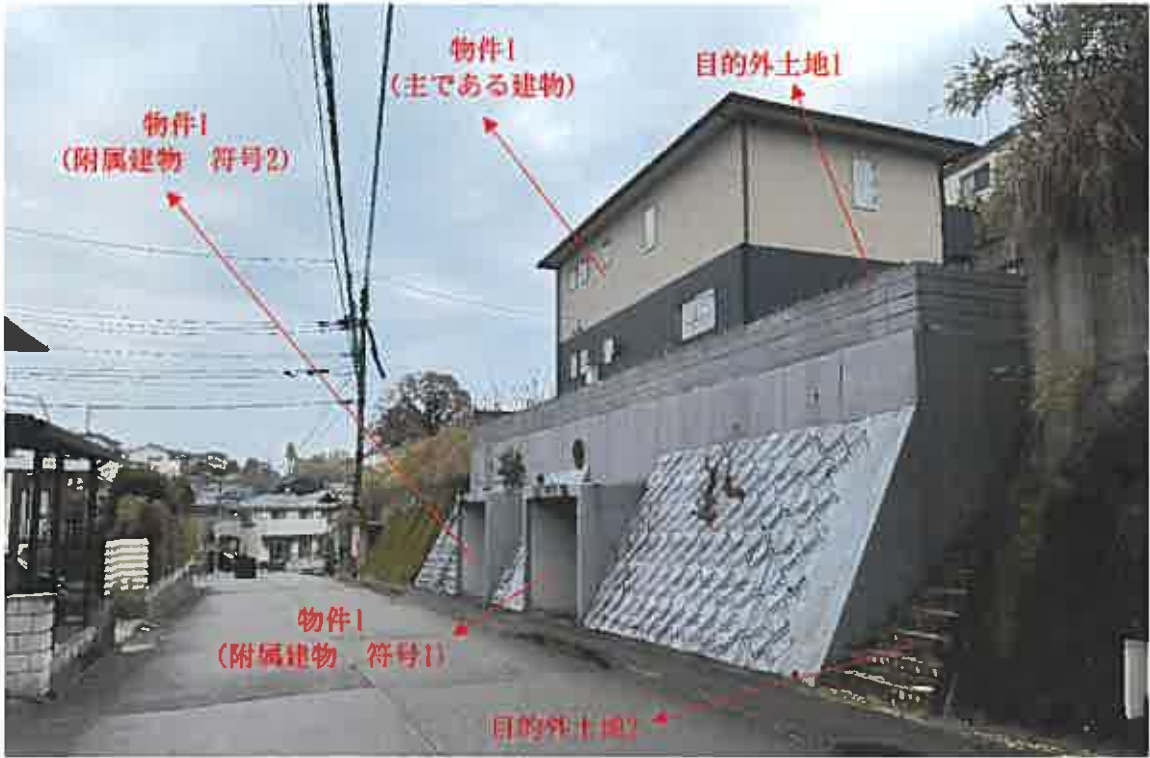
南西方より対象不動産を望む
