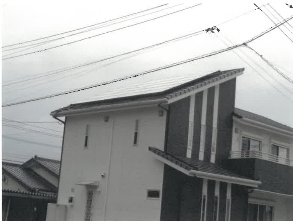
(写真2) 物件2の建物に設置されている太陽光発電システム
