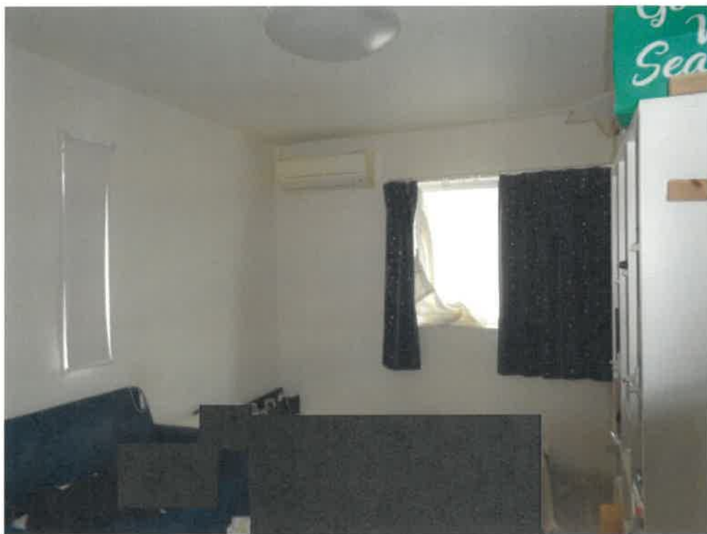
(写真 1 5) 物件 2 の建物内部 (2 階)
