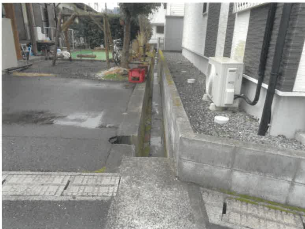
(写真8) 物件8の用悪水路
