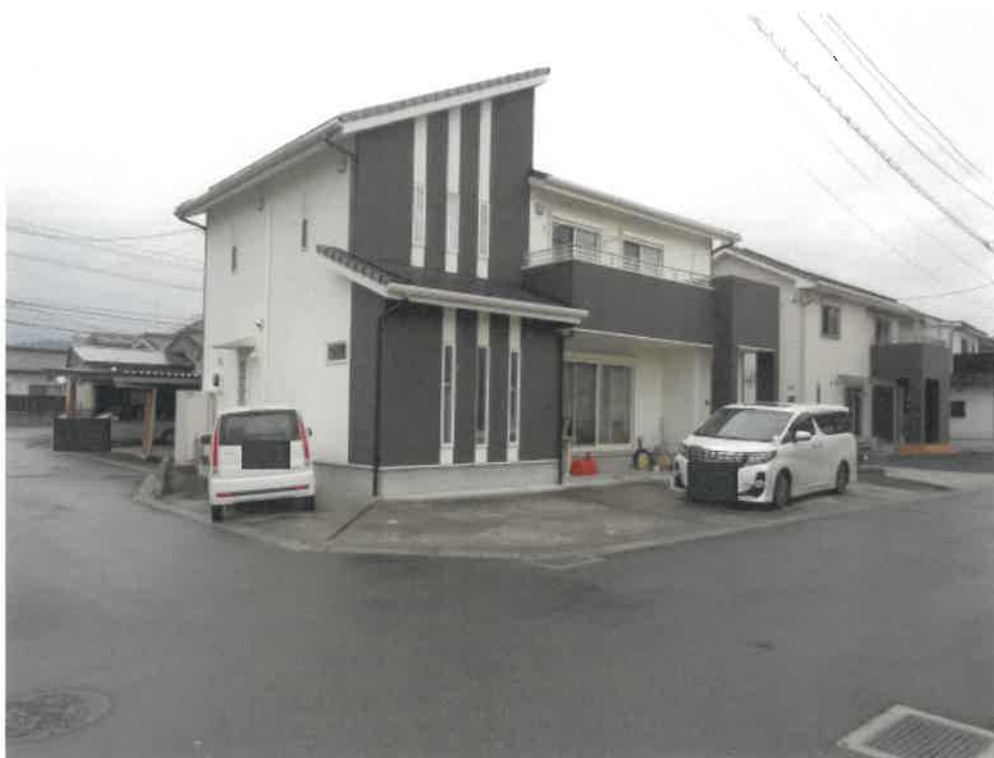
(写真1) 物件1及び2の土地建物全景
