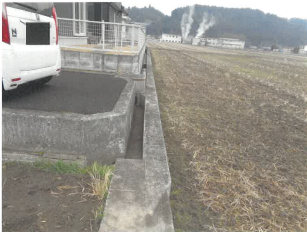
(写真7) 物件7の用悪水路
