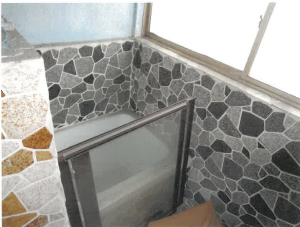
(写真10) 物件2の建物内部(2階)
