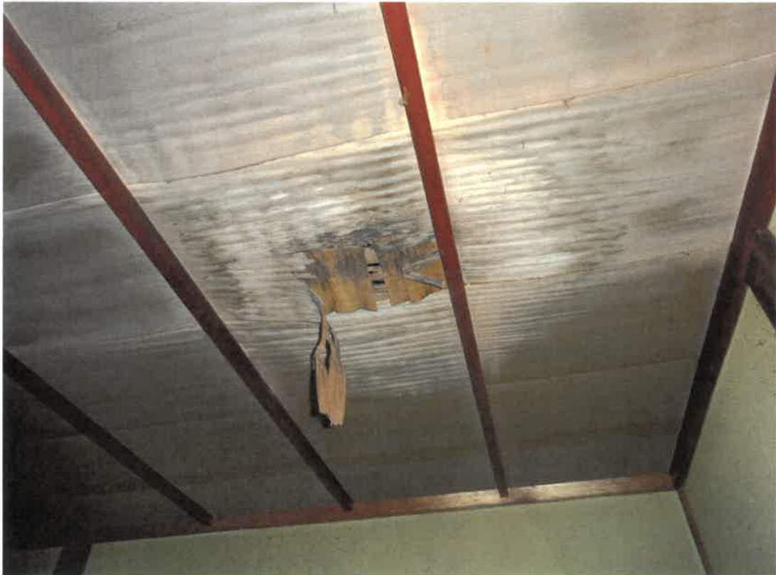
物件2（主である建物）内部 1階和室天井の雨漏りによる劣化箇所
