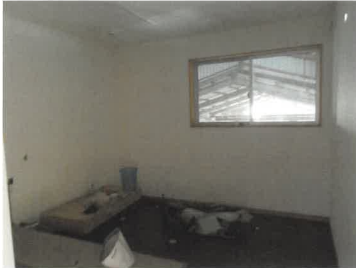
写真⑪建物内部
