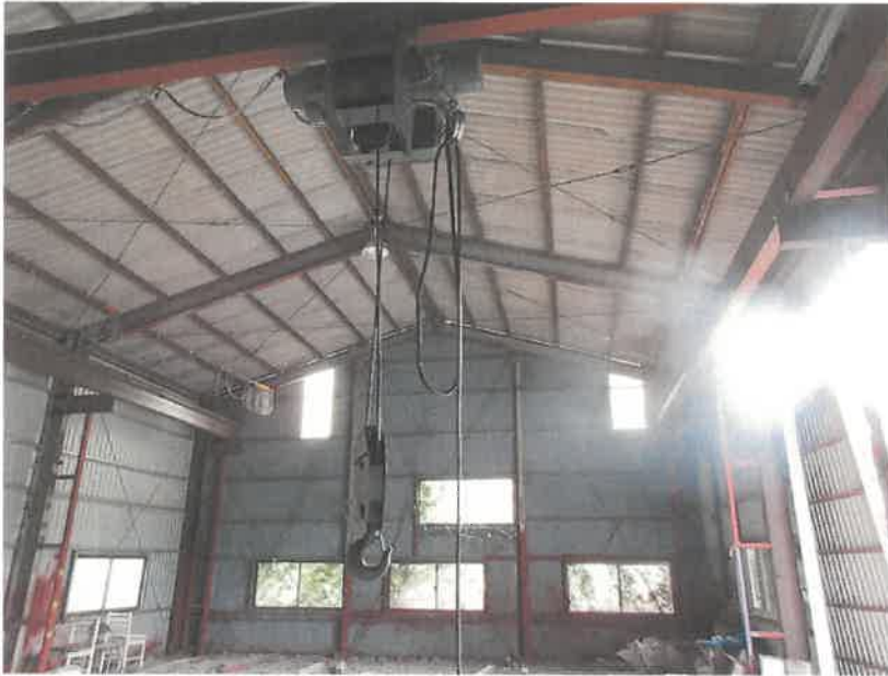
物件 6 工場内の機械器具
