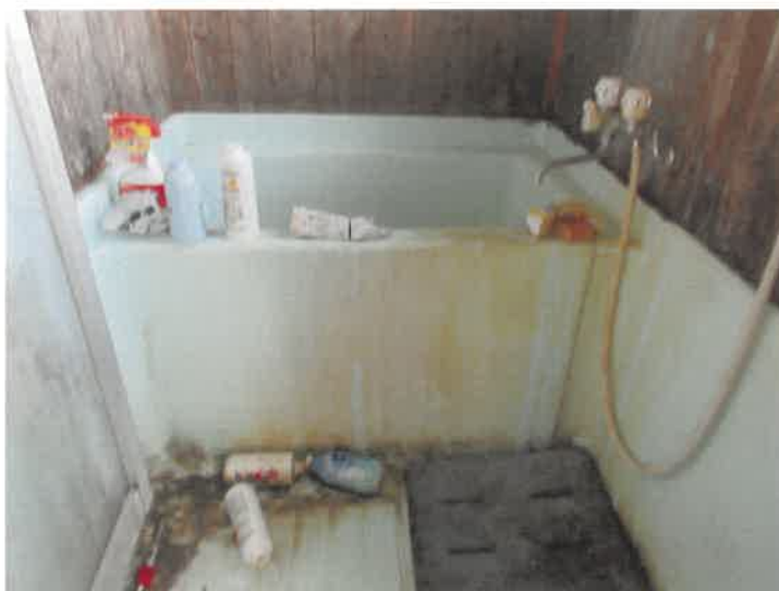
写真⑰建物内部
