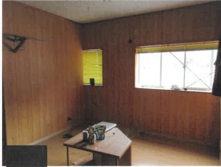
写真⑭建物内部
