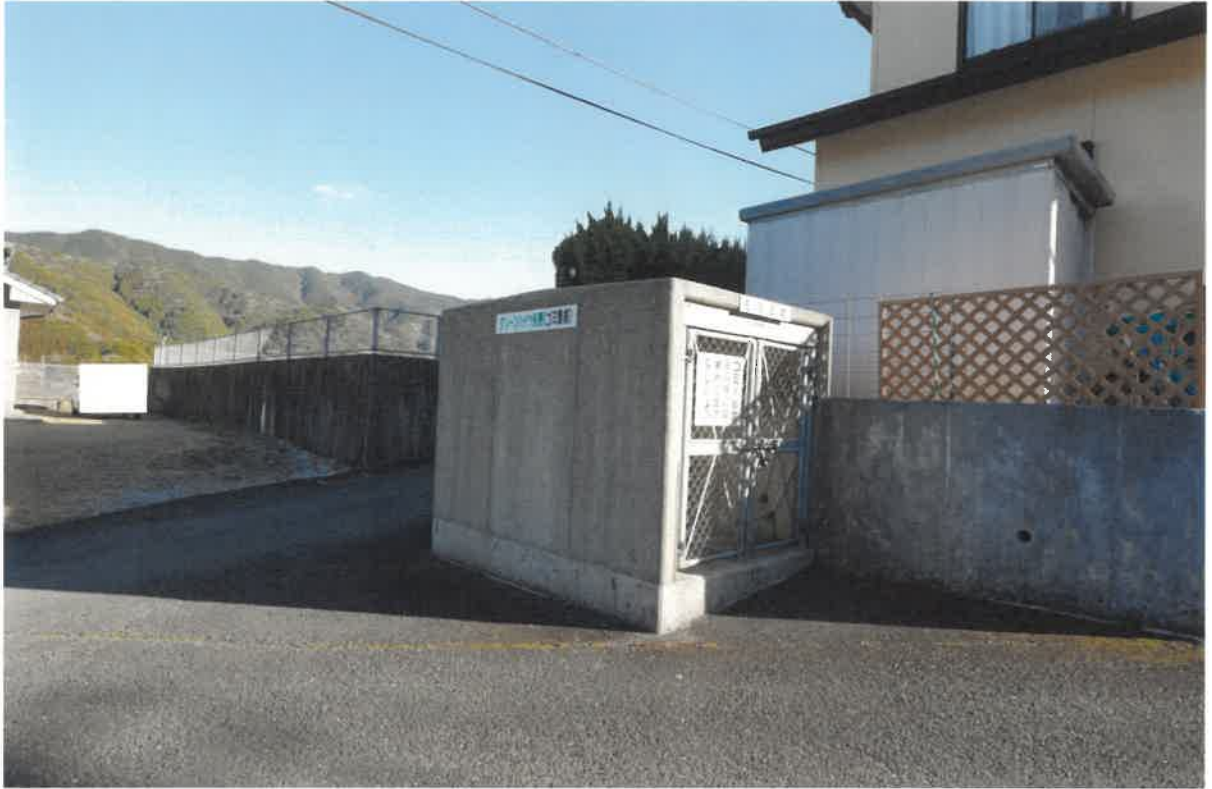
(写真⑪) 売却対象工作物ア コンクリート製ゴミ置場
