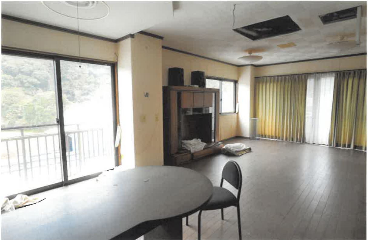
(写真⑳) 本件建物(物件4)の内部
