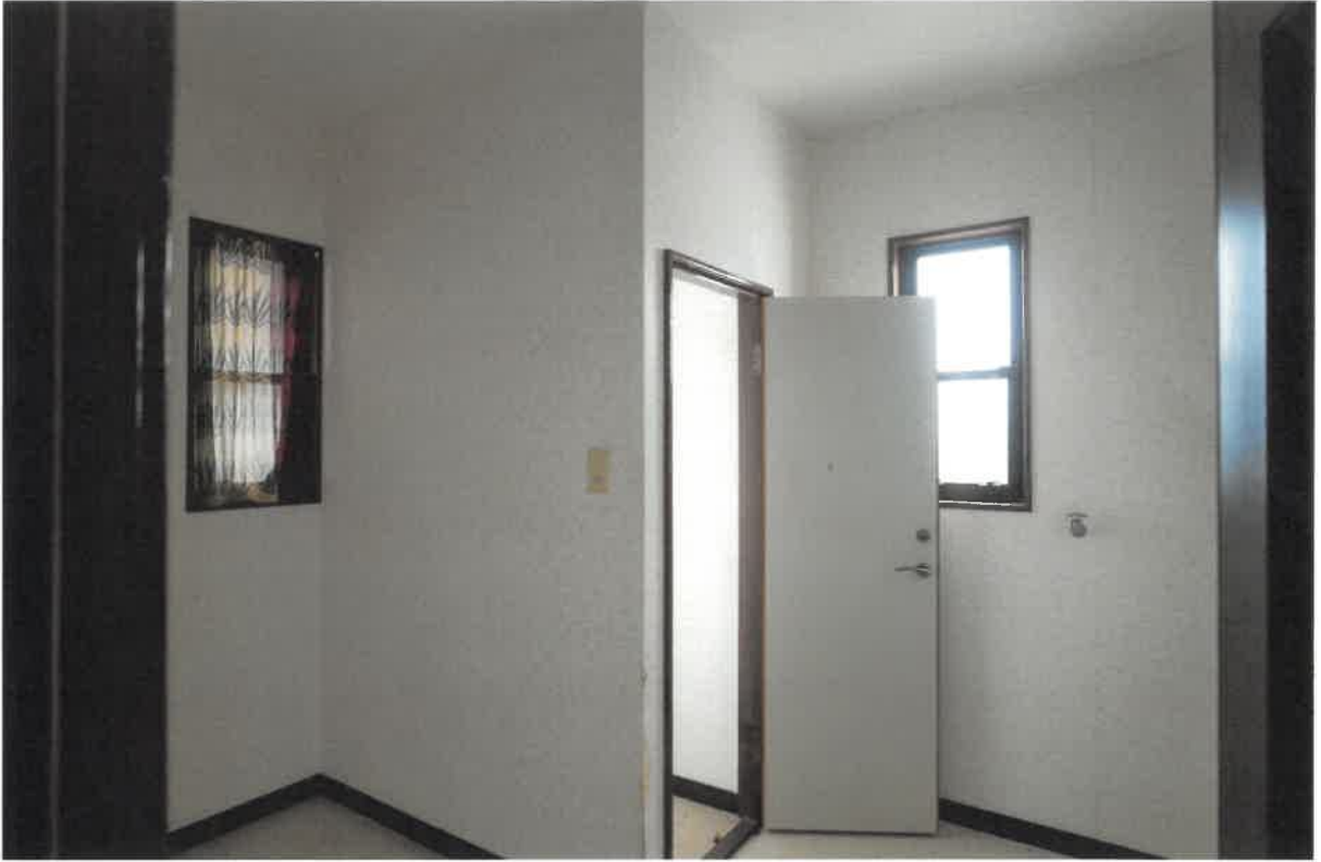
(写真⑳) 本件建物(物件4)の内部
