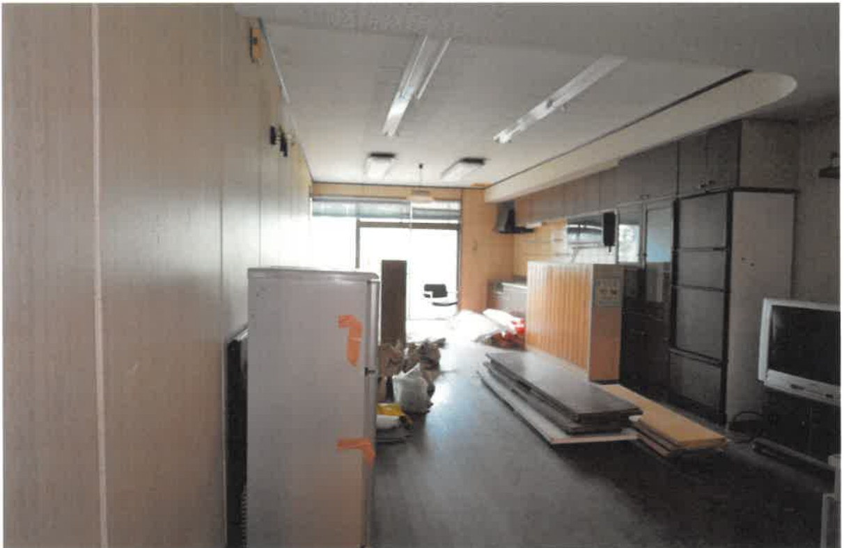
(写真⑧) 本件建物(物件3)の内部
