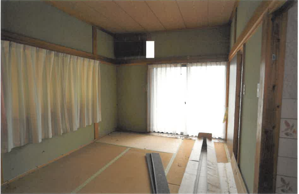
(写真⑦) 本件建物(物件3)の内部
