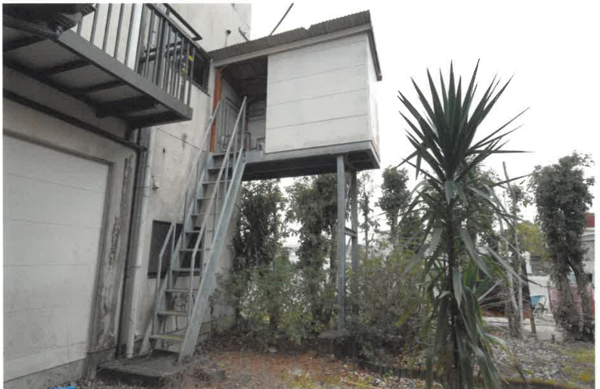
(写真④) 物件4建物の売却対象工作物鉄骨製ボイラー庫
