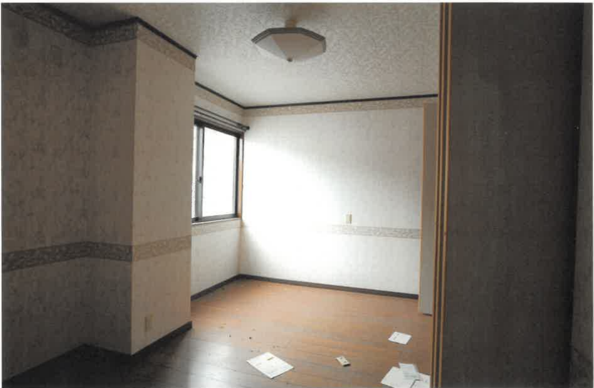
(写真㉑) 本件建物(物件4)の内部
