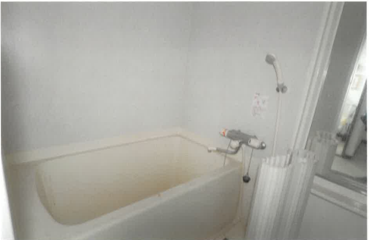
(写真㉑) 本件建物(物件4)の内部
