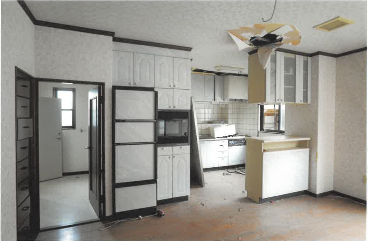
(写真⑳) 本件建物(物件4)の内部
