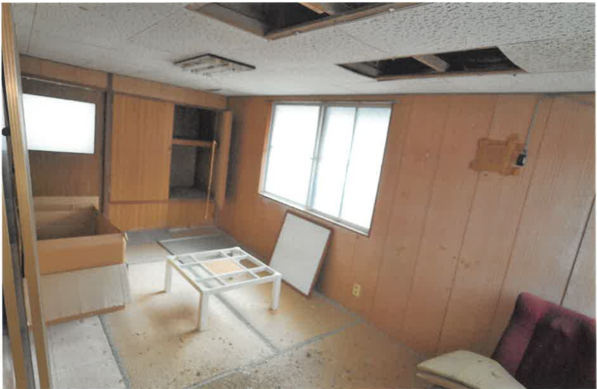
(写真⑭) 本件建物(物件3)の内部
