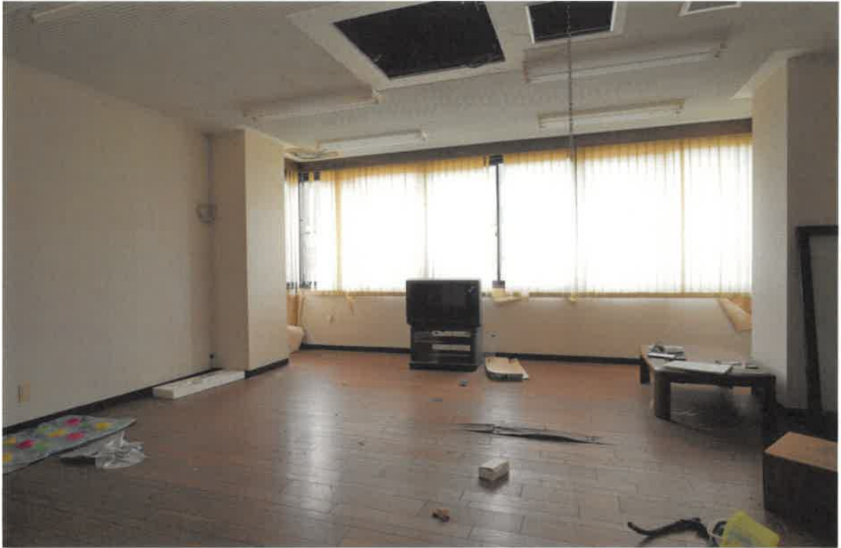
(写真⑳) 本件建物(物件4)の内部
