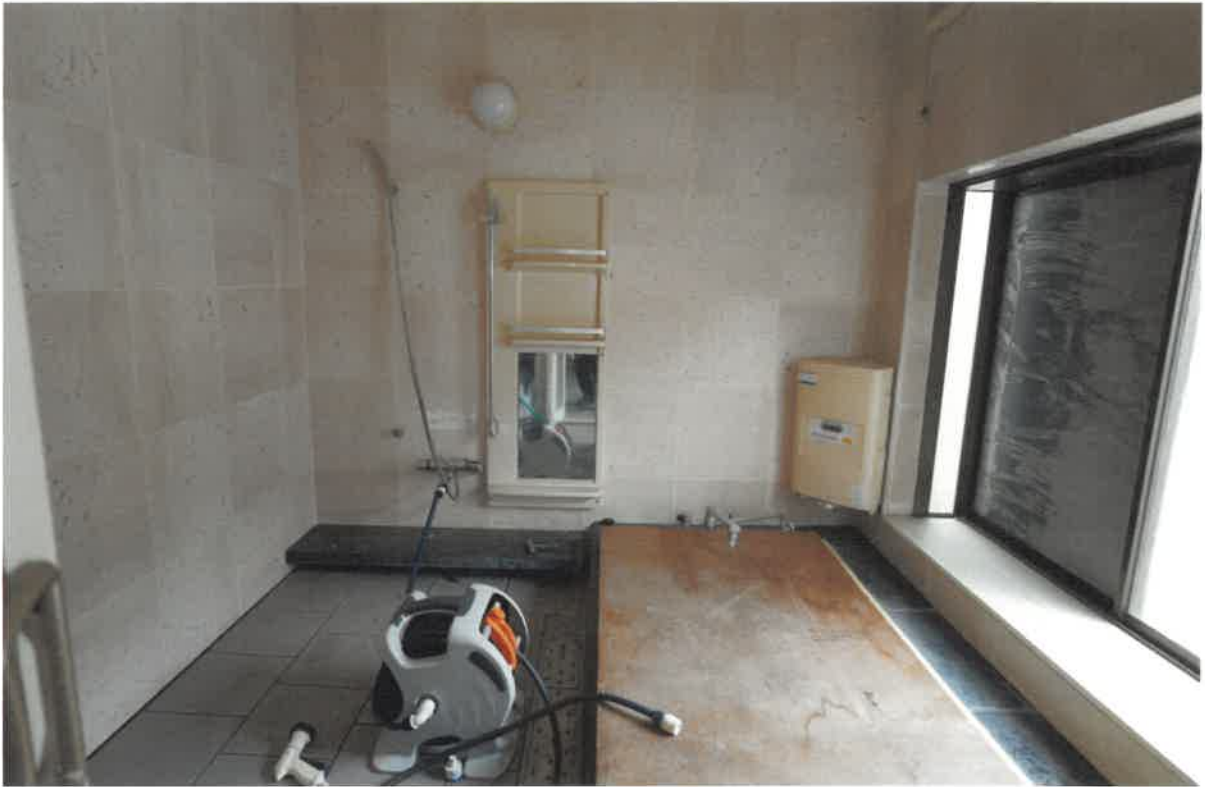
(写真⑨) 本件建物(物件3)の内部
