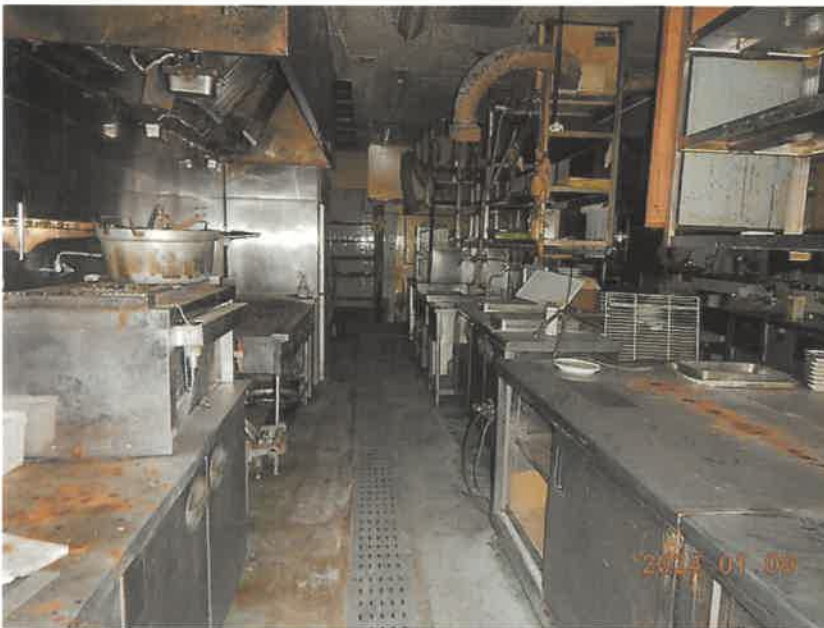
物件 5 厨房内の状態
