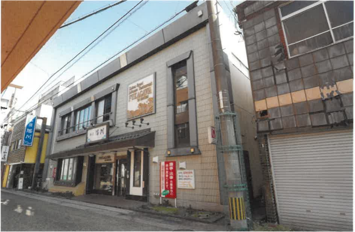
(写真①) 本件土地・建物の全景
