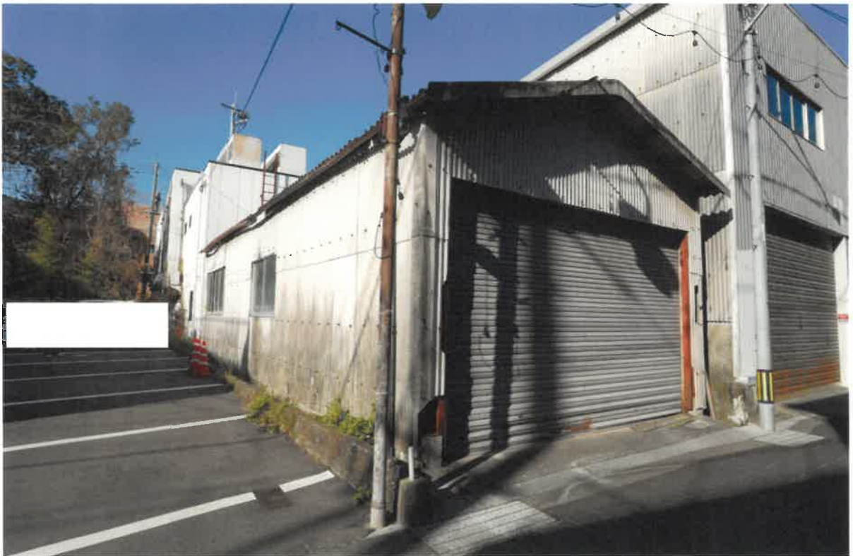
(写真②) 本件土地・建物の全景
