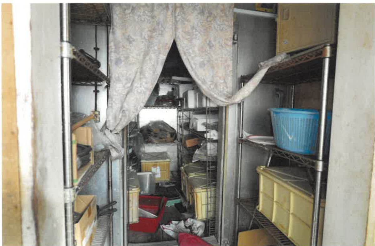
(写真⑩) 本件建物の内部
