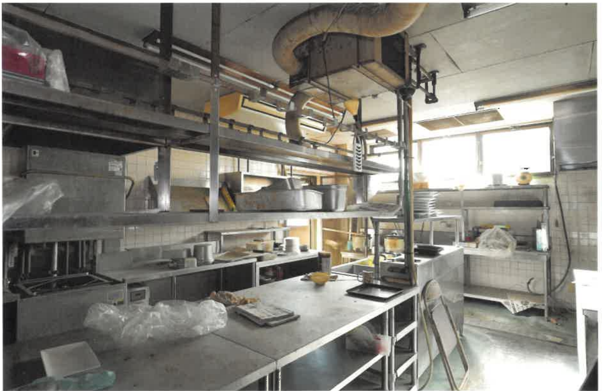
(写真④) 本件建物の内部
