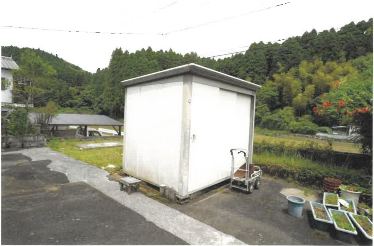
(写真③) 売却対象工作物スチール製物置
