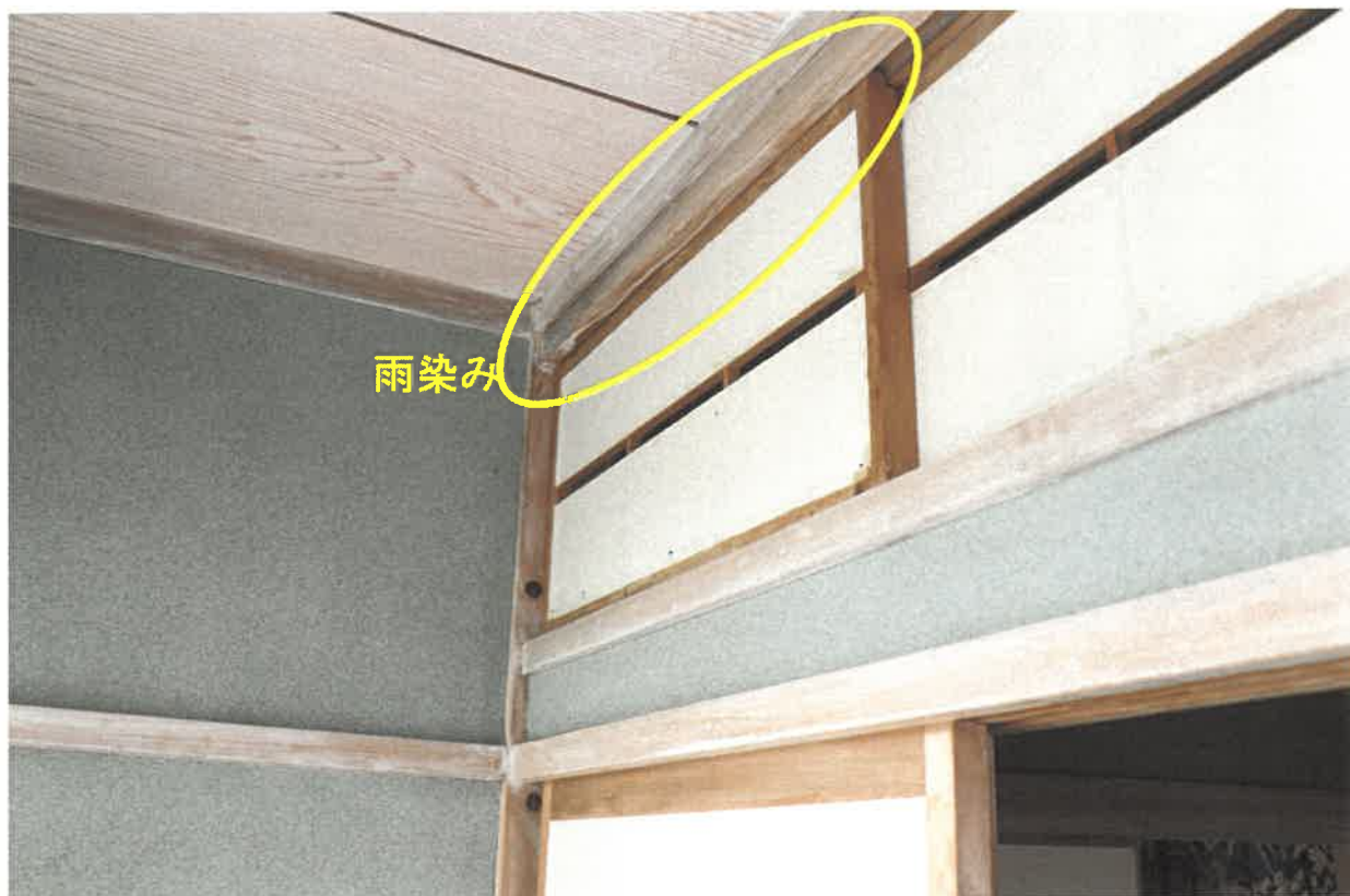
1階；東側くれ縁
