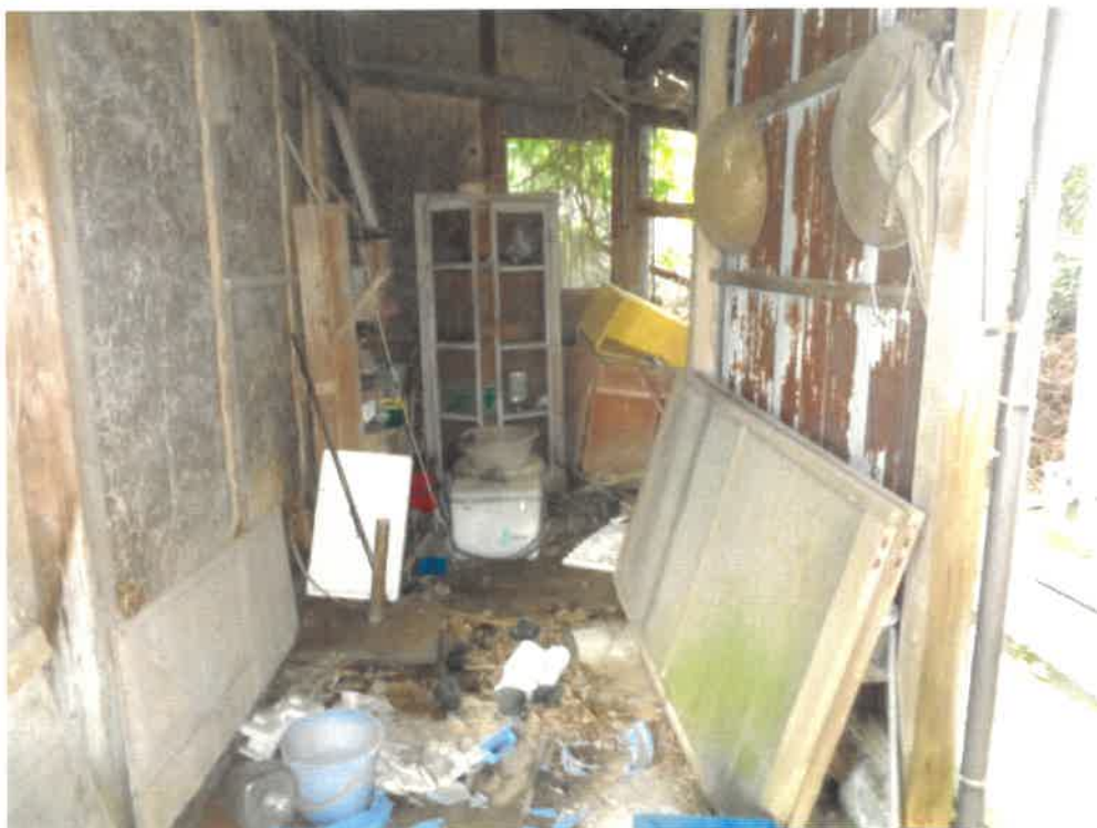
(写真18) 符号1の附属建物内部
