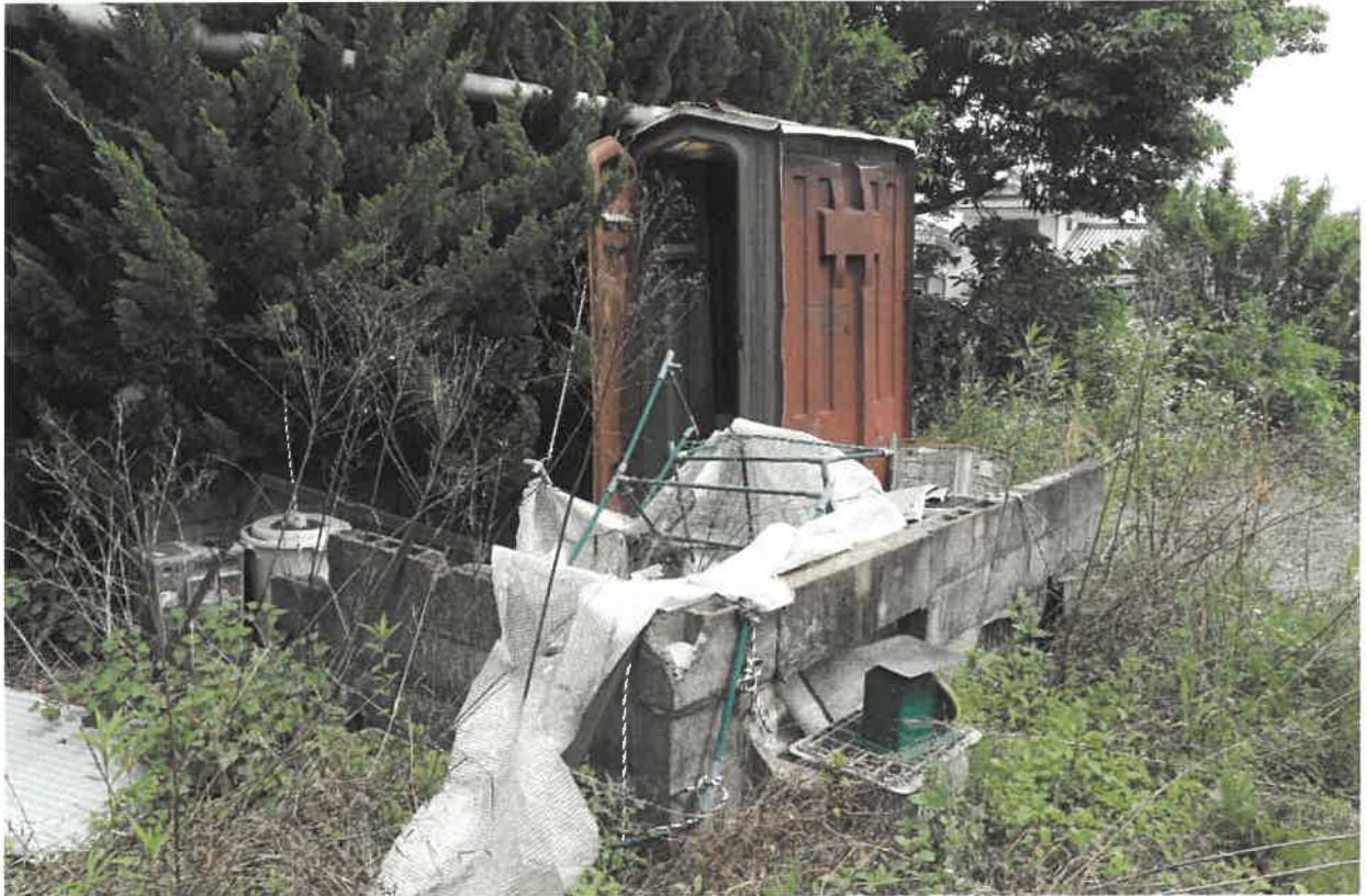
売却対象工作物（仮設便所）
