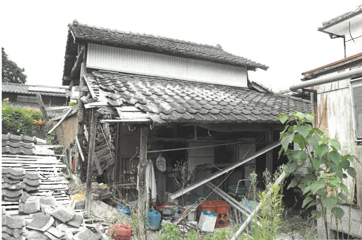
物件5；附属建物（存続部分）
