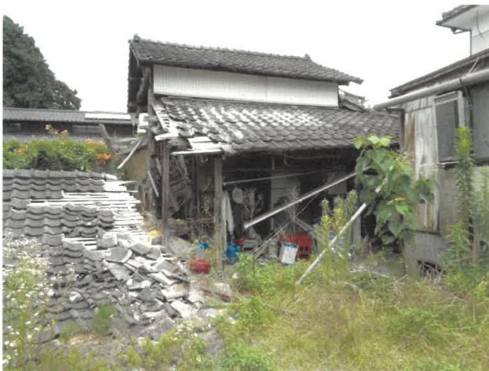
(写真 3) 符号 1 の附属建物 (残存部分)
