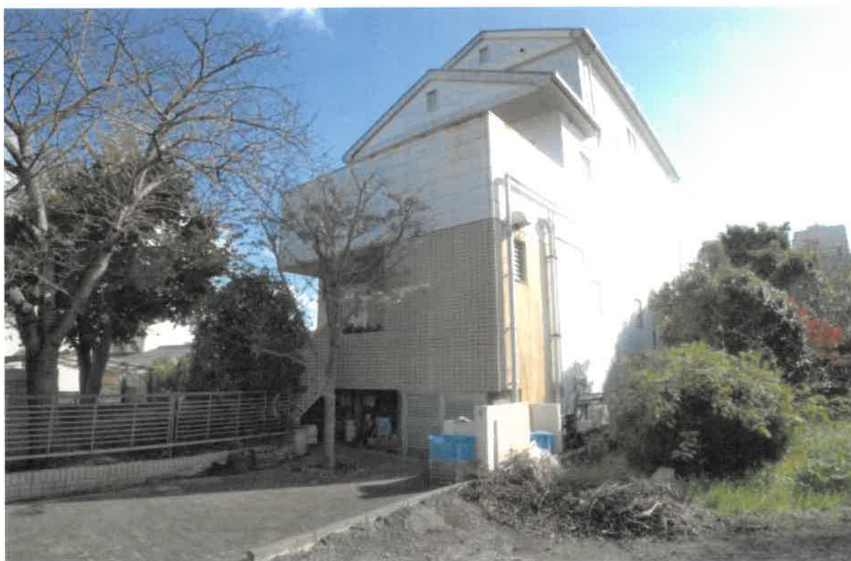
(写真②) 本件土地・建物の外景
