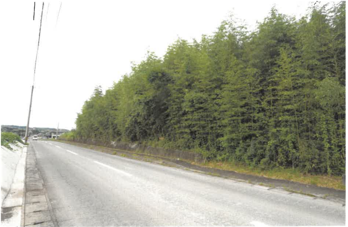
(写真①) 本件土地(物件16)の全景
