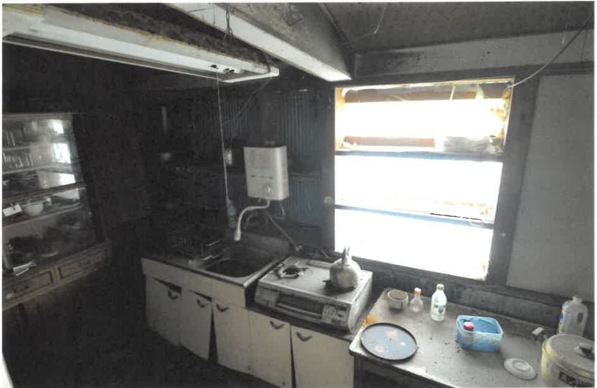
(写真⑪) 本件建物(物件6)の内部
