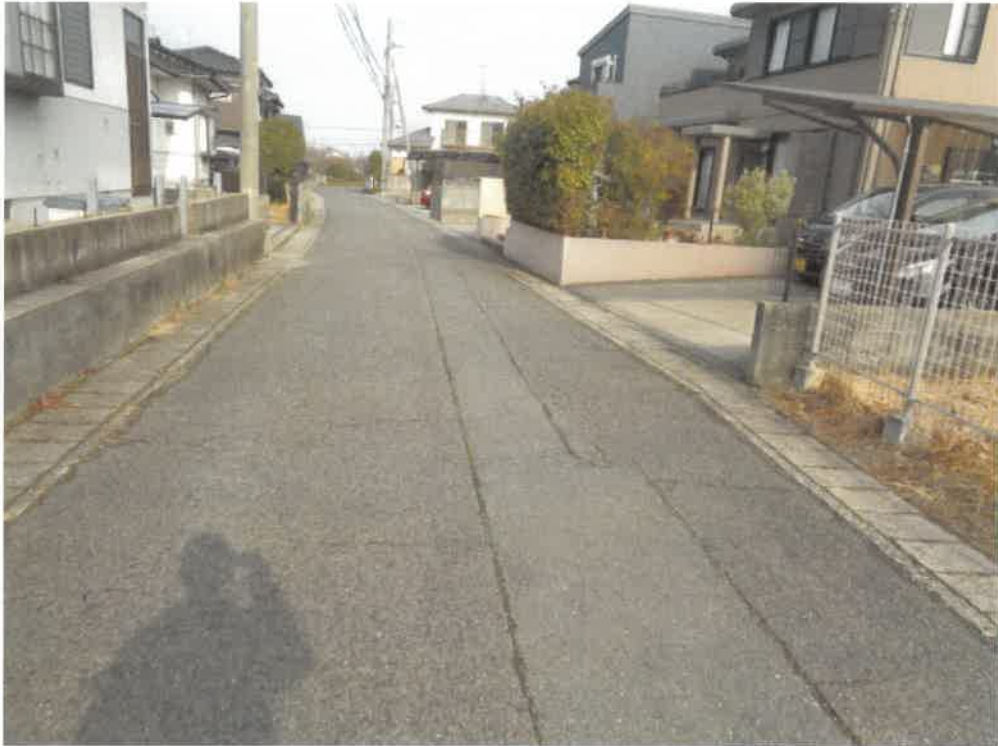
(写真2) 本件土地の接面道路
