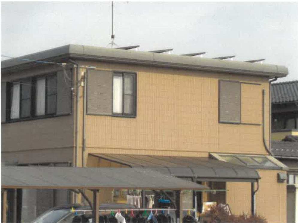
(写真3) 本件建物に備え付けられている太陽光発電システム（パネル）
