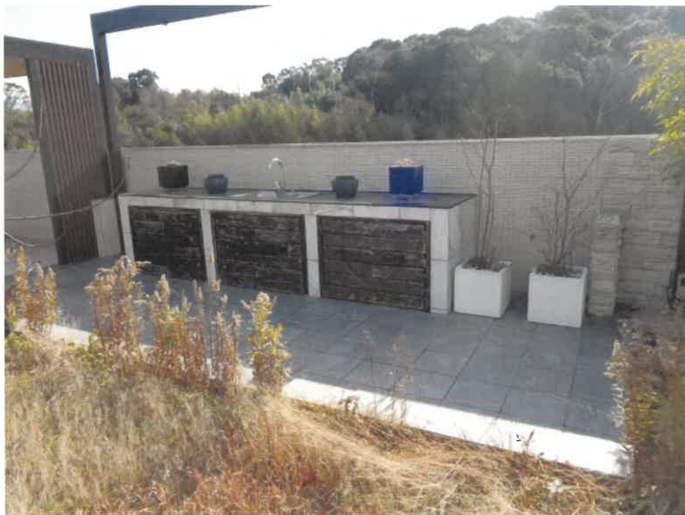
(写真14) 屋外キッチン
