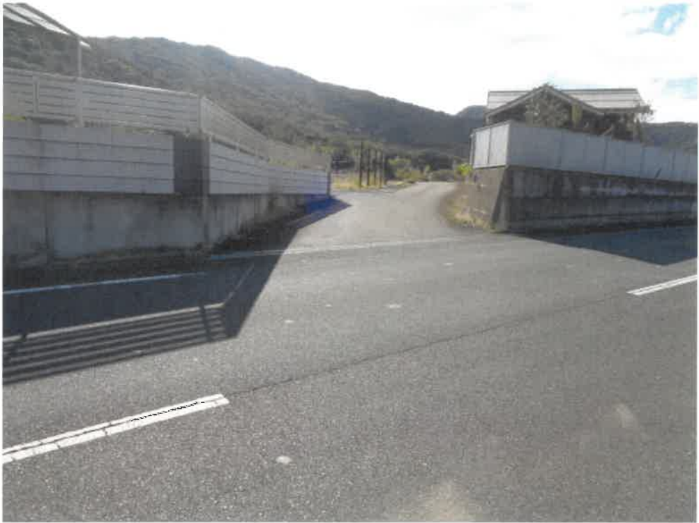
(写真5) 本件土地の接面道路(市道)
