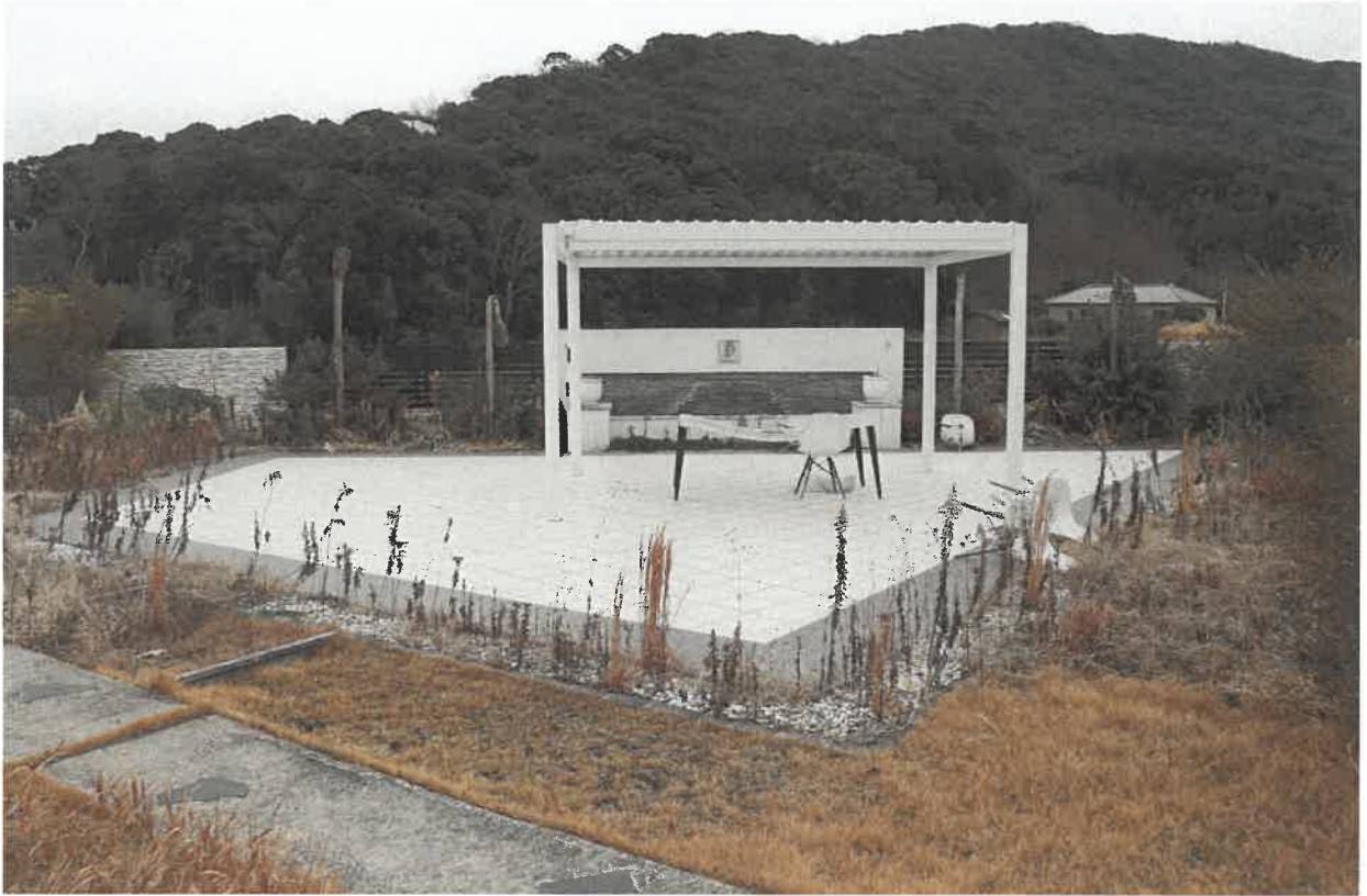
庭園設備（鉄骨製パーゴラ）
