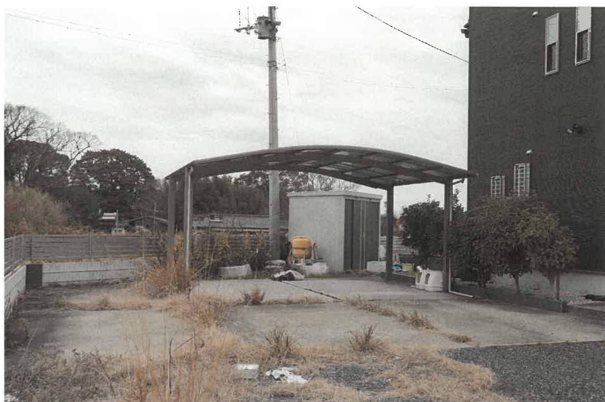
カーポート・スチール製物置、引込電柱
