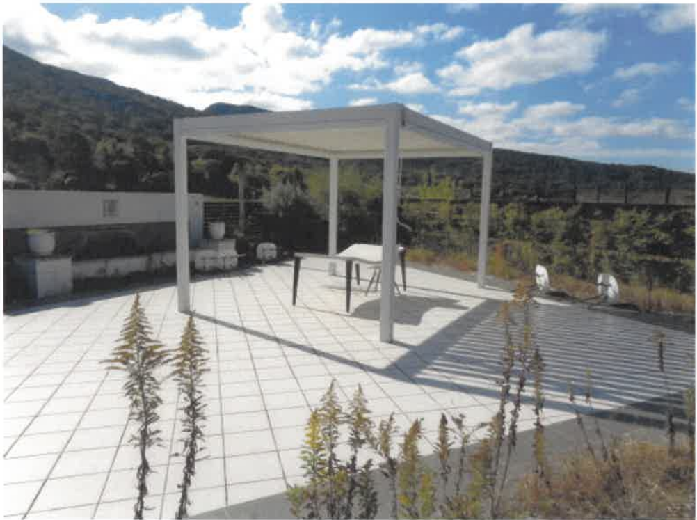
(写真12) 鉄骨製パーゴラ
