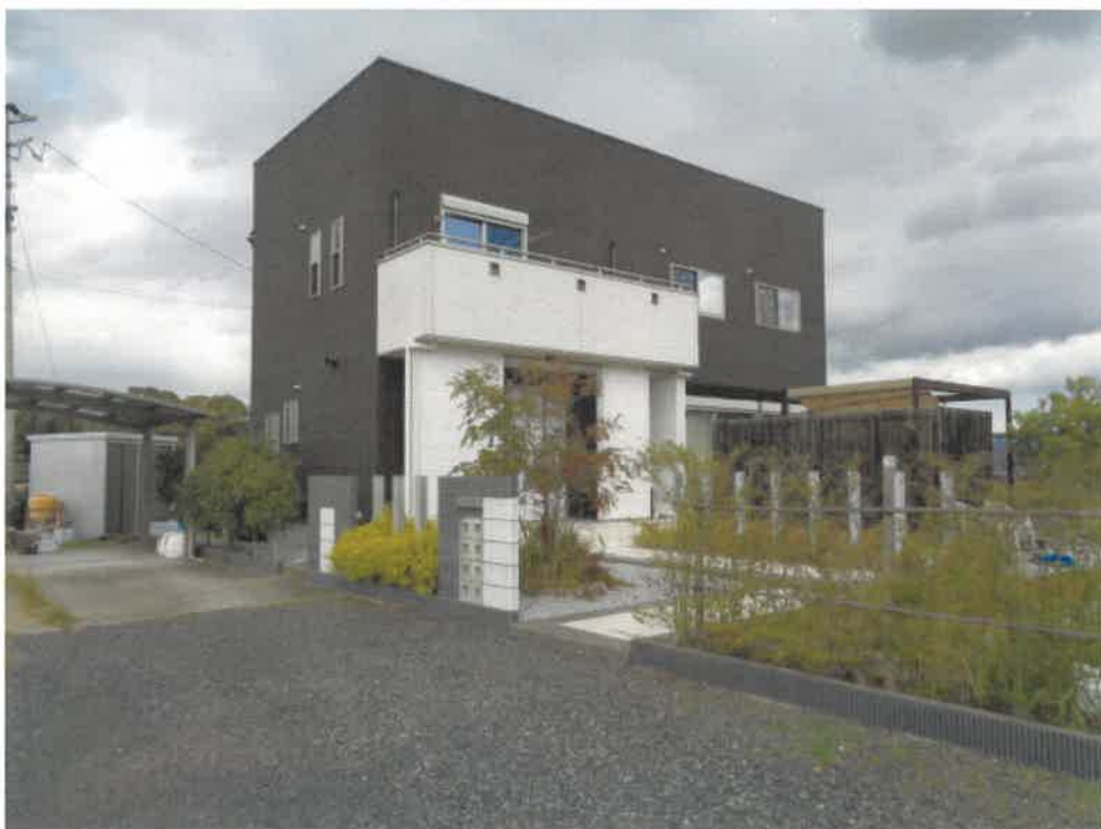
(写真3) 本件建物
