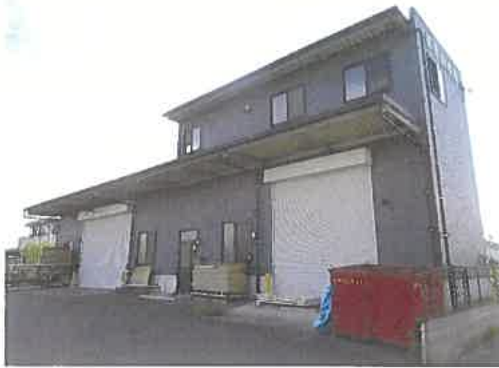
写真②廃材コンテナ
