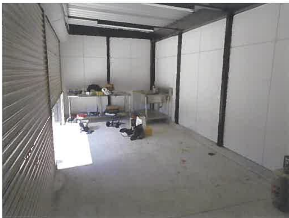
(写真 1 2) 本件建物の附属建物内部
