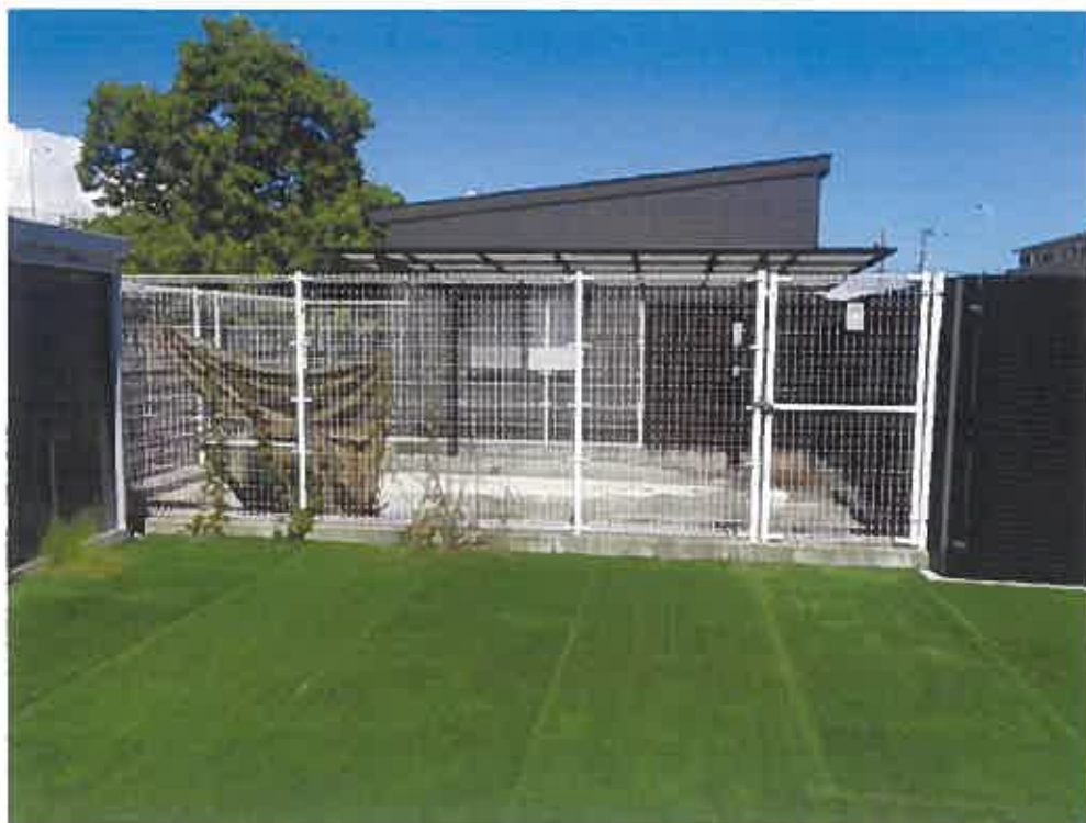
(写真6) 売却対象物件（土地の定着物）であるアルミ製フェンス及びカーポート
