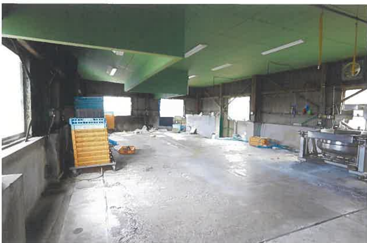
(写真52) 本件建物17の内部
