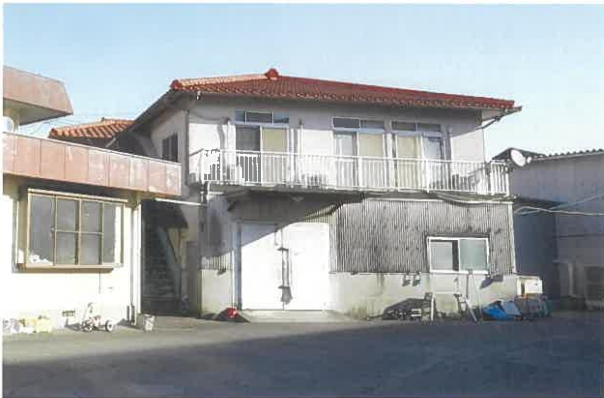
(写真③①) 本件建物7の外観
