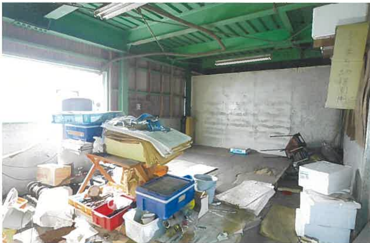
(写真41) 本件建物7の内部
