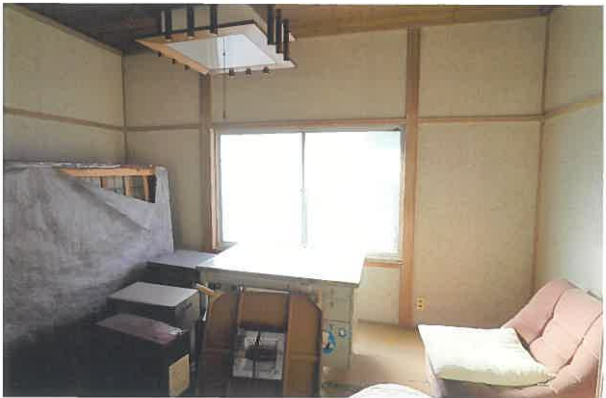
(写真⑥) 本件建物4の内部
