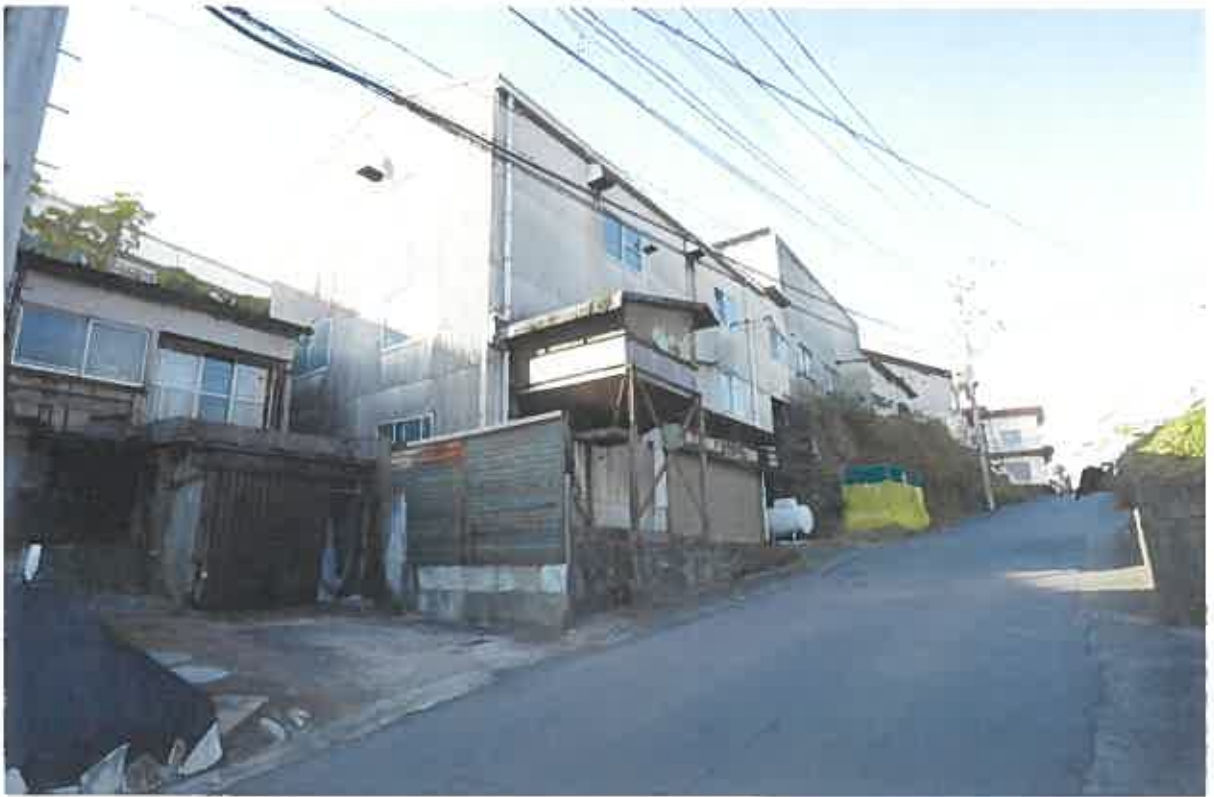
(写真48) 本件建物17の外観
