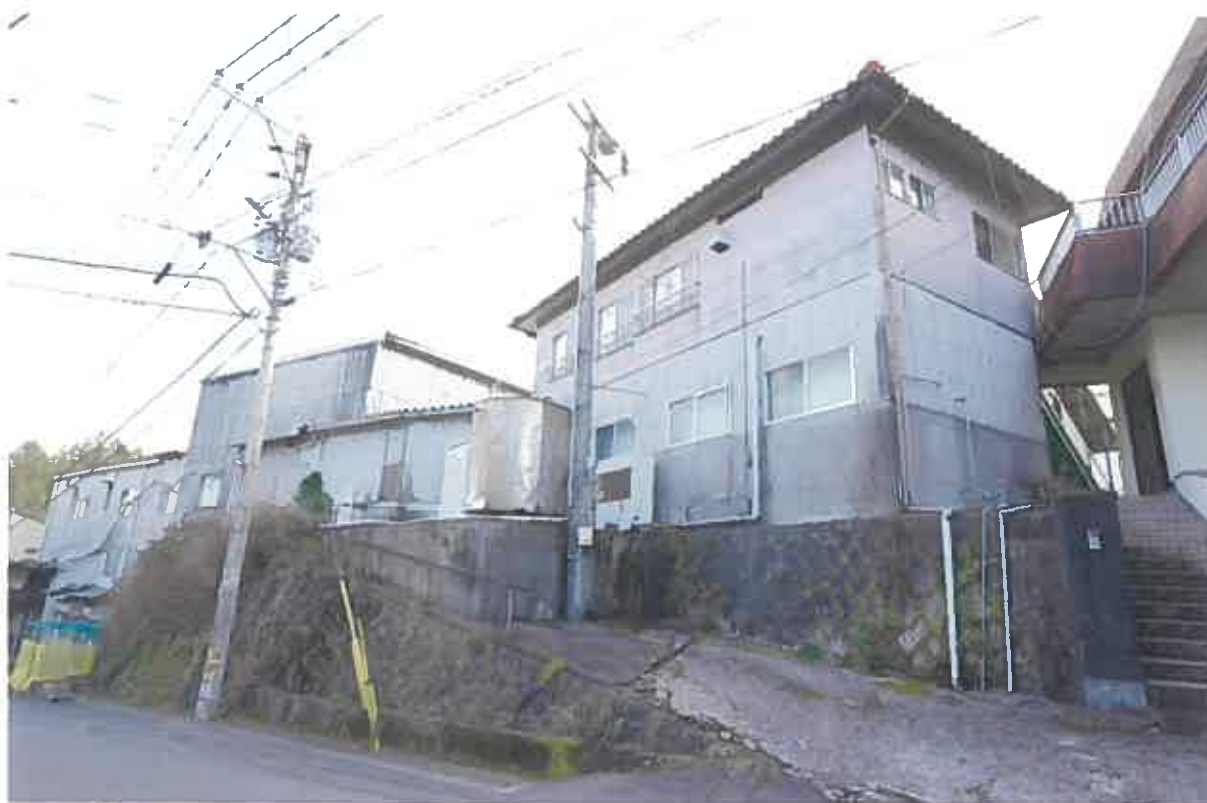
(写真30) 本件建物7の外観
