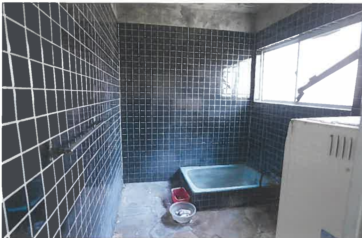
(写真⑨) 本件建物4の内部
