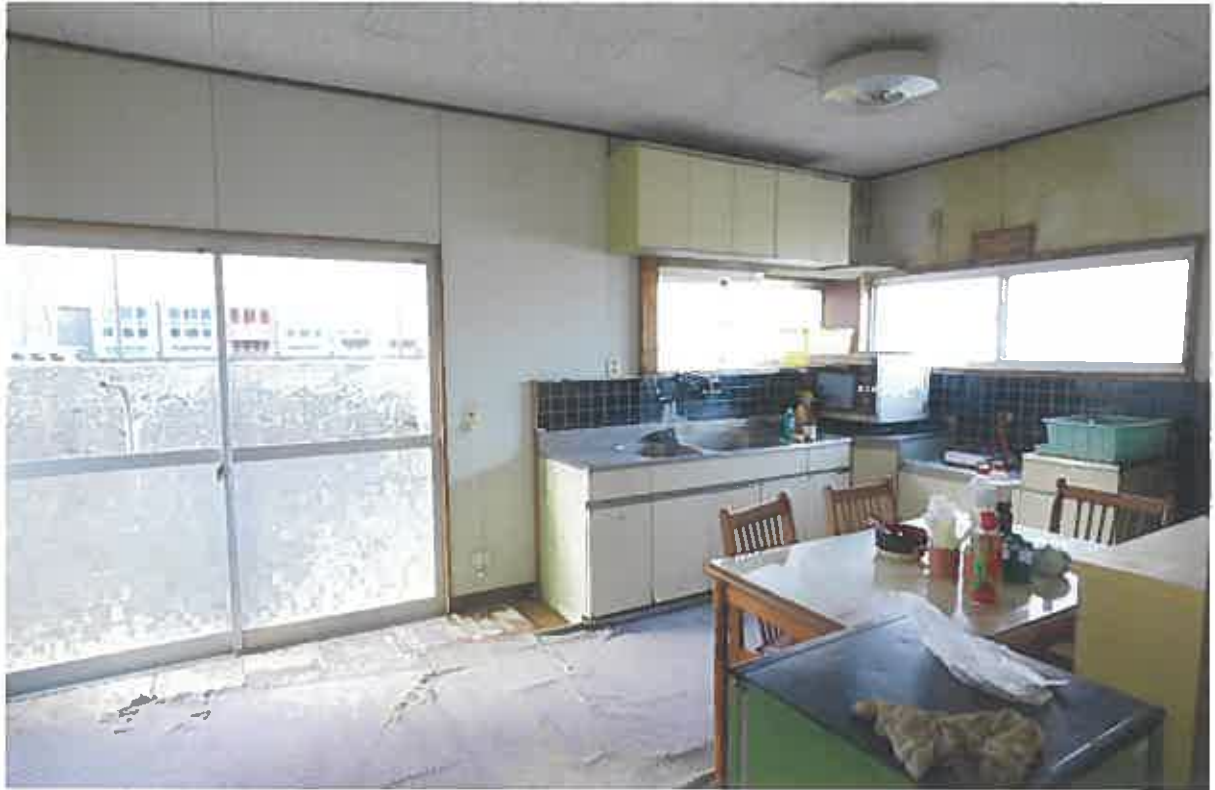
(写真⑦) 本件建物4の内部
