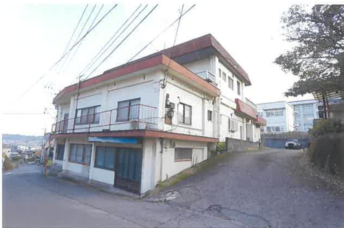
(写真⑩) 本件土地2, 3, 本件建物6の外観
