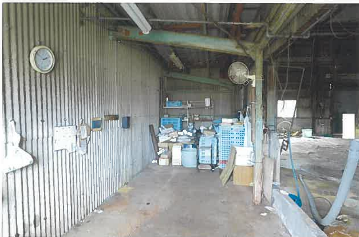
(写真51) 本件建物17未登記附属建物の内部
