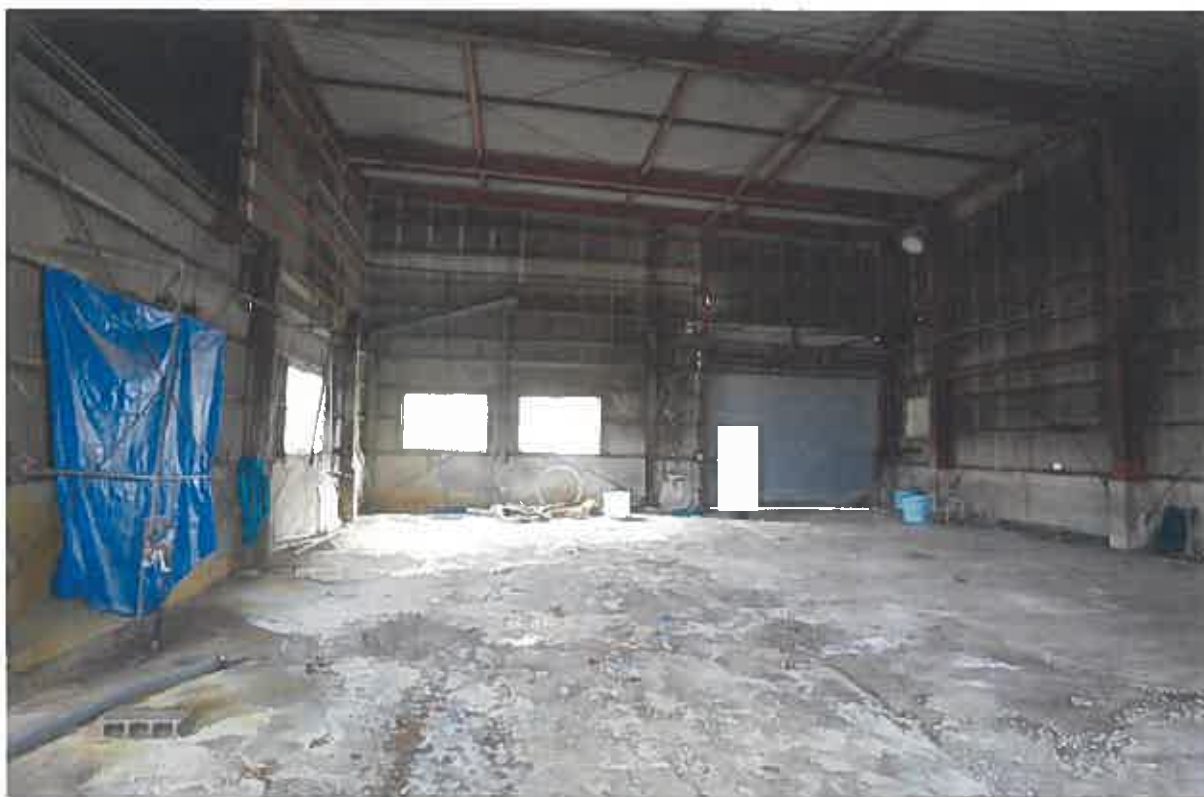
(写真50) 本件建物17未登記附属建物の内部
