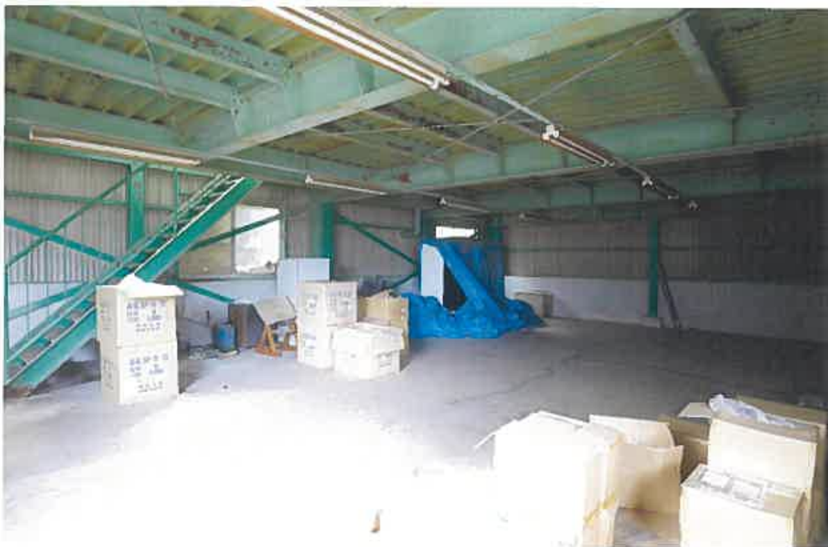
(写真55) 本件建物17の内部
