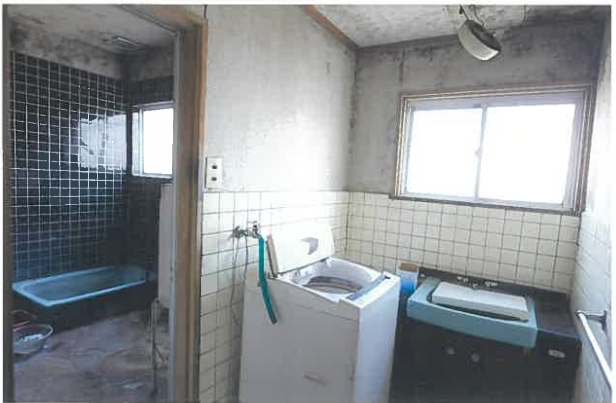
(写真⑧) 本件建物4の内部
