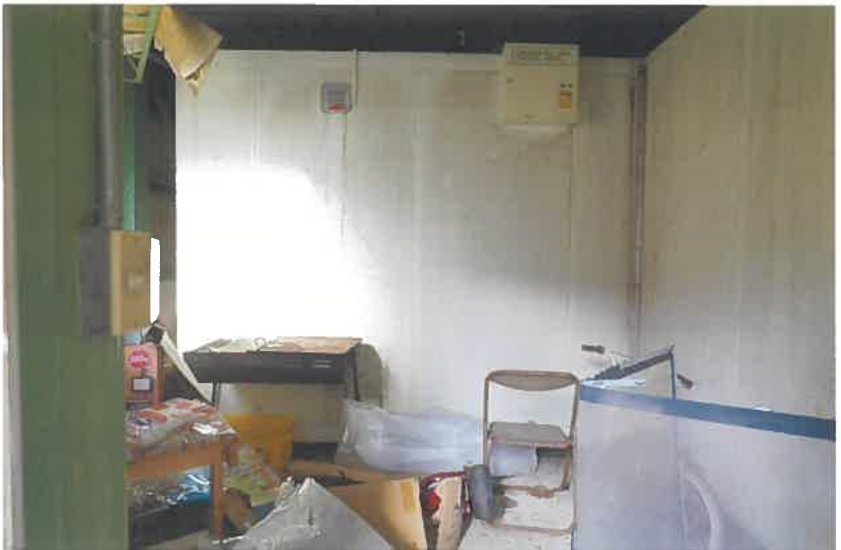
(写真③④) 本件建物7の内部
