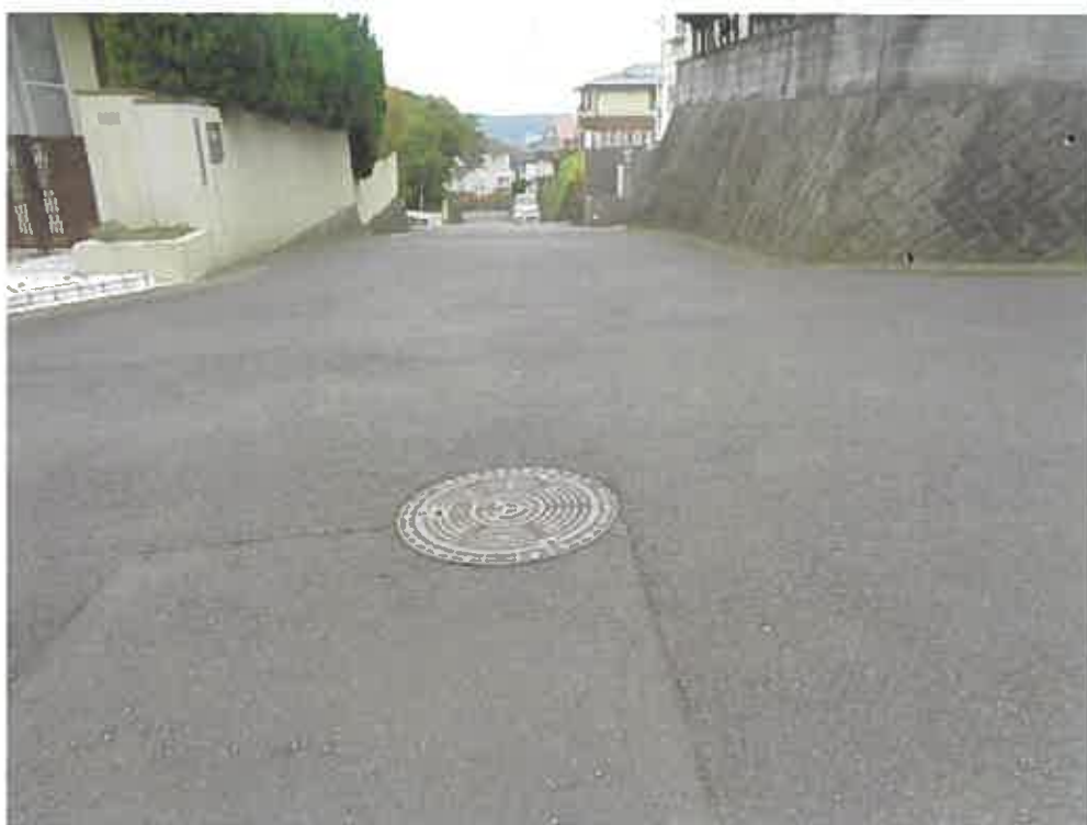
(写真3) 本件土地の接面道路
