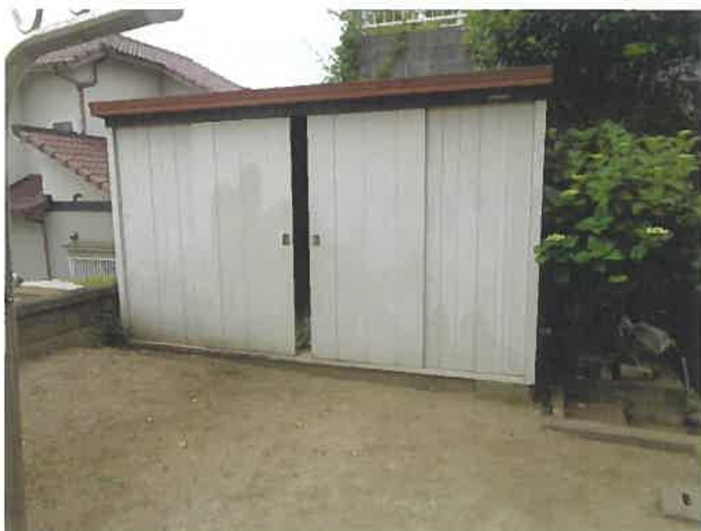
(写真5) 売却対象物件(従物)であるスチール製物置
