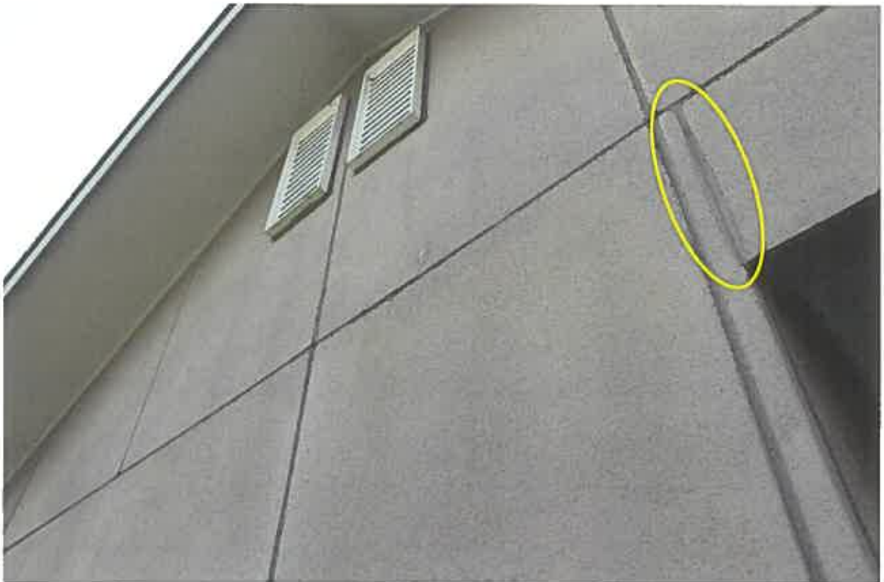
外壁の汚損・目地補修状況
