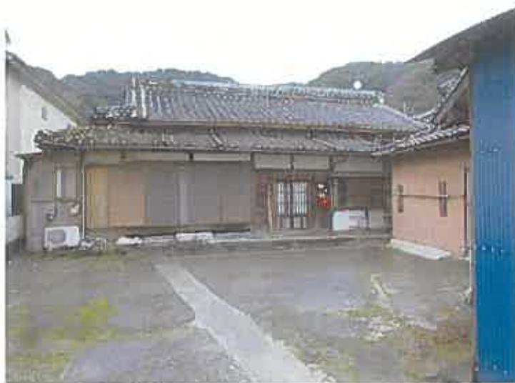
写真②附属建物
