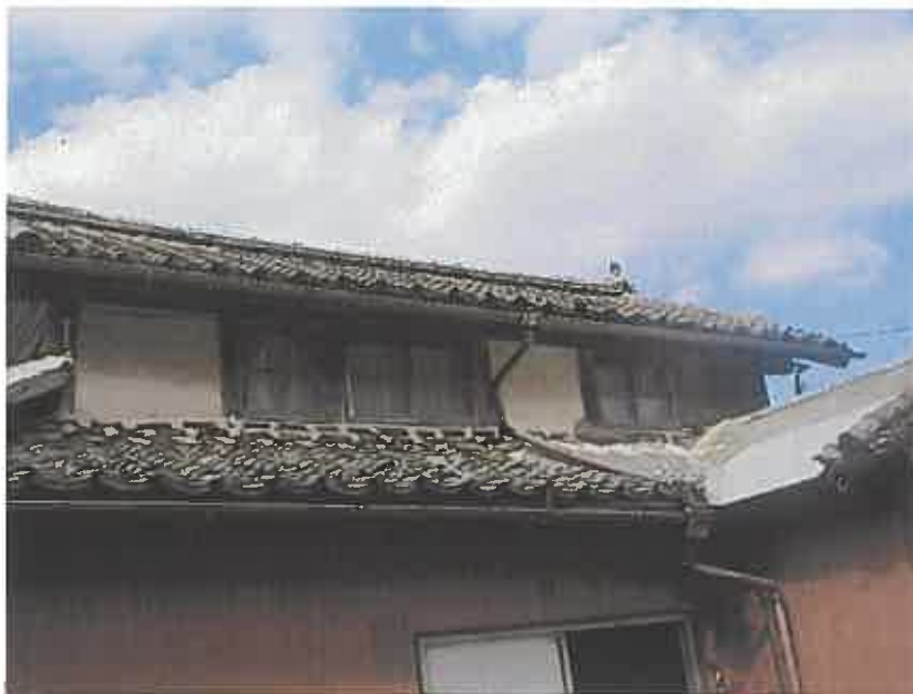
物件 2（附属建物） 屋根部分
