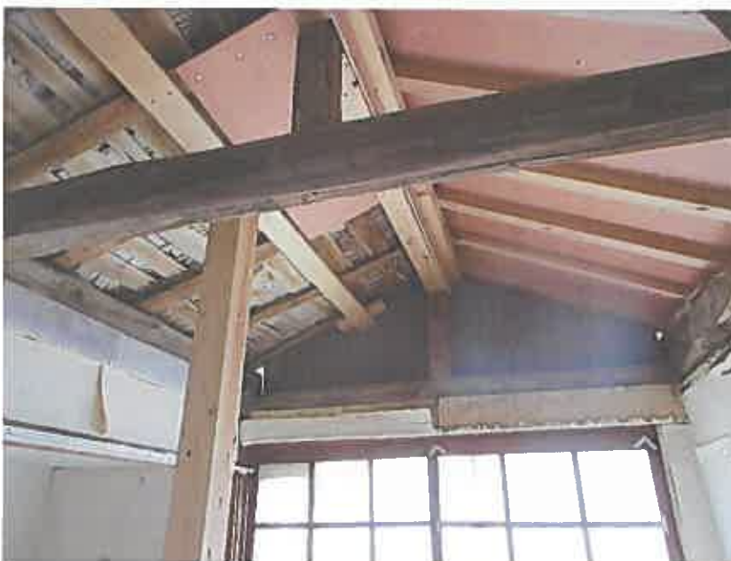
物件 2（附属建物） 天井部分
