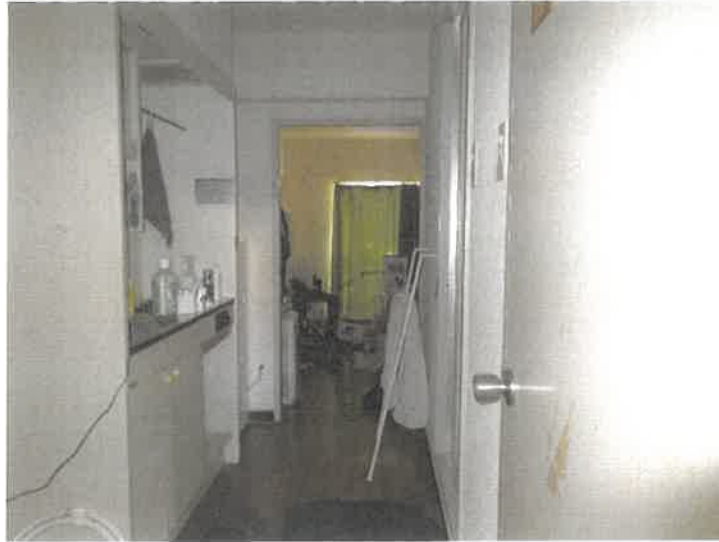
写真③⑧本件建物（物件 8） 1 A 7
