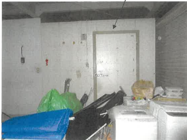
写真⑭ プレハブ式ユニットハウス
