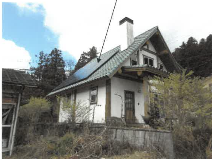
写真②ヒートポンプ給湯器
