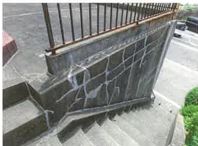
鉄柵の腐食状況
