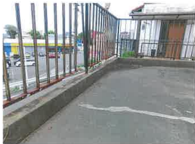
鉄柵の腐食状況
